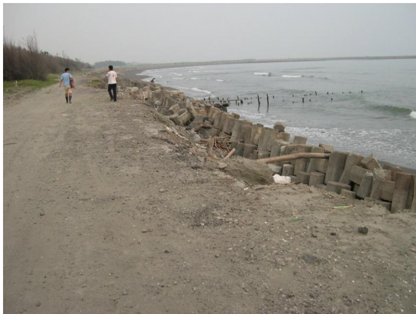
圖 3-6 上圖海岸的現場拍攝照片(2005)
