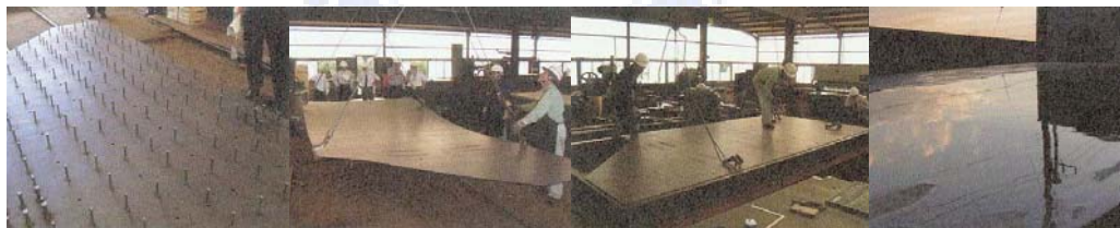
圖 4-18. 1：TOD'S 一案配筋與施工大樣圖 2：Mikimoto 的鐵板夾混凝土三明治結構工廠施工情形
