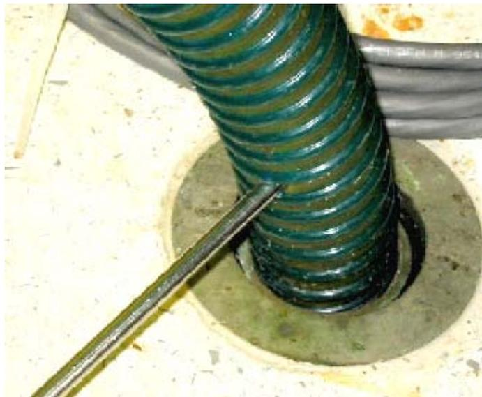
圖 3.6 真空管末端採樣點
