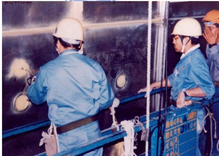
圖 16 氨氣濃度測試孔
