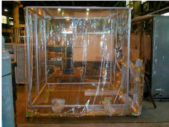
圖 19 實施槽側邊補修時之氮氣室
