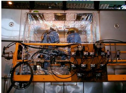
圖 20 實施儲槽角部補修之氮氣室
