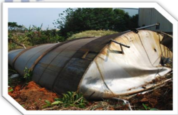
圖 2：協明化工災害現場(1)
