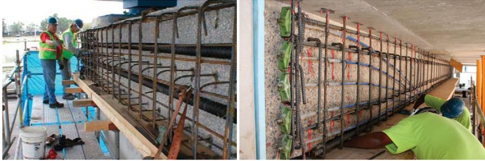
圖 2.2 擴展式外置預力補強工法[7]
