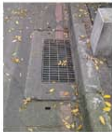
基地邊緣之水溝
