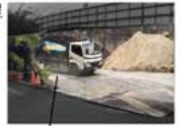
位於原地面高程之沙石場
