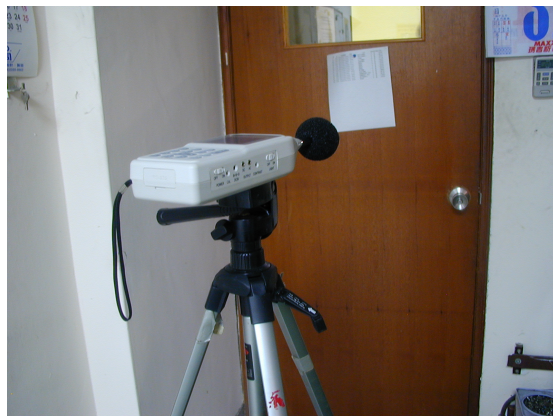
圖 4-9 控制室隔音鐵門加上 原有一道木門關閉
