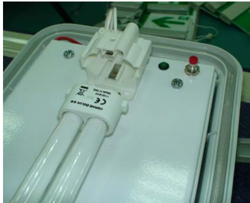
圖 58 國外緊急照明燈燈頭座連接方式 資料來源：本研究拍攝
