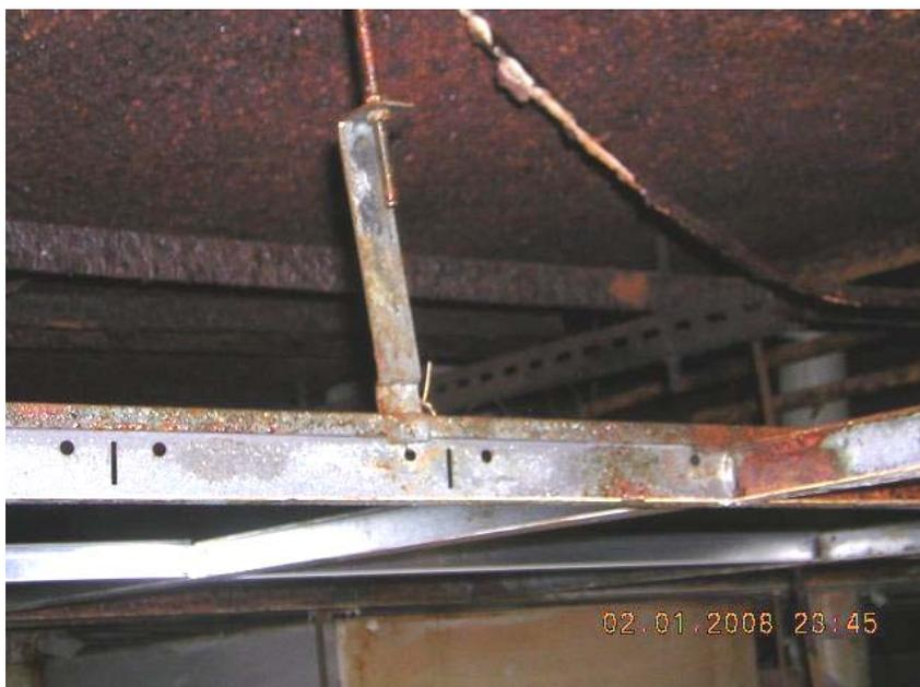
圖 1.2 天花板輕鋼架鏽蝕情形-2
