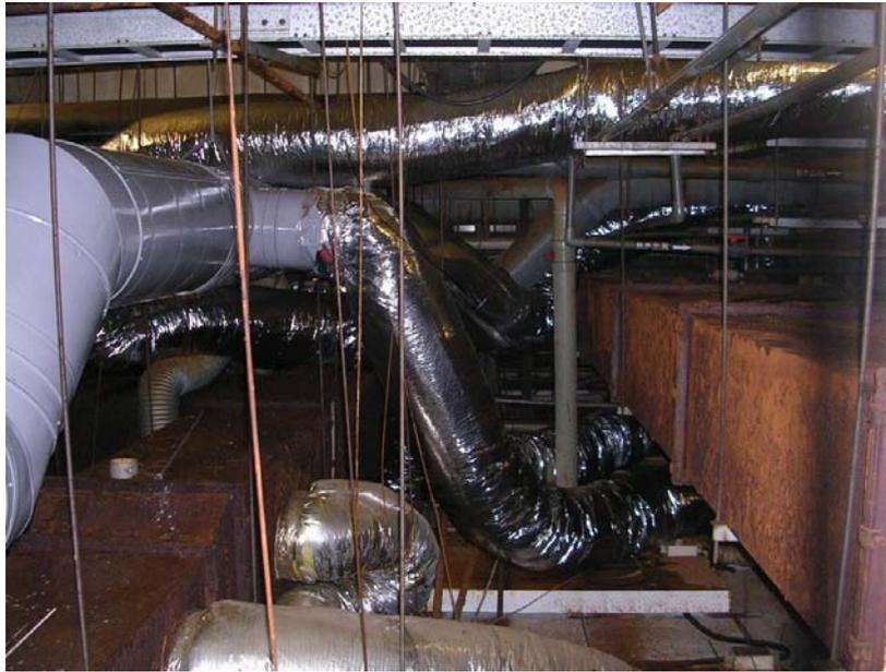
圖 1.3 貓道內吊筋、空調管路鏽蝕情形
