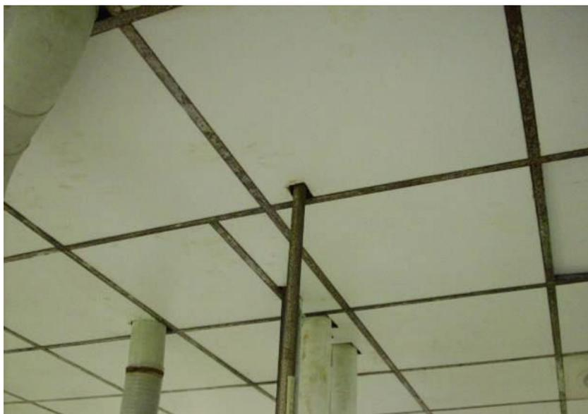
圖 1.1 天花板輕鋼架鏽蝕情形-1
