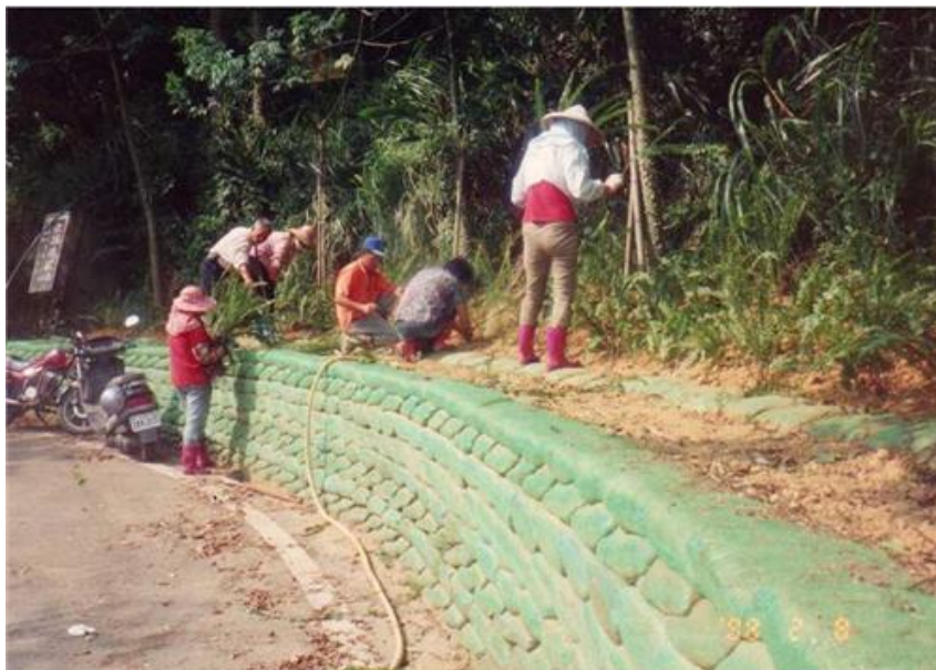
圖十七 邊坡土袋之堆置
