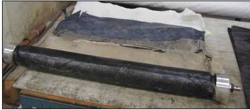
圖 4-32 包覆材拆卸完成
