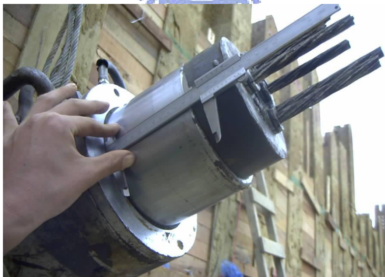
圖 20 案例 3 - 地錨背拉外支撐施工法照片
