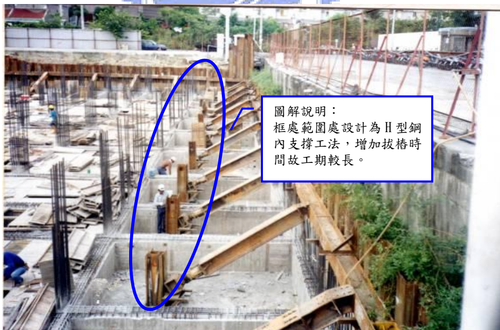
圖 18 案例 3 - H 型鋼內支撐施工法照片
