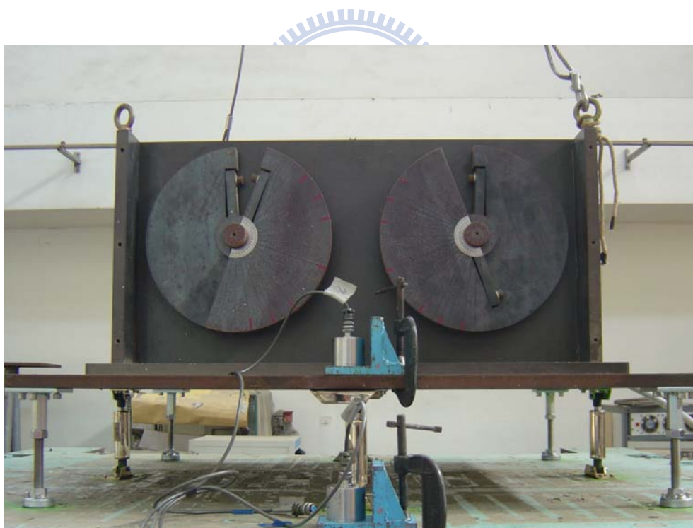
圖 5.7 激振器安裝完成
