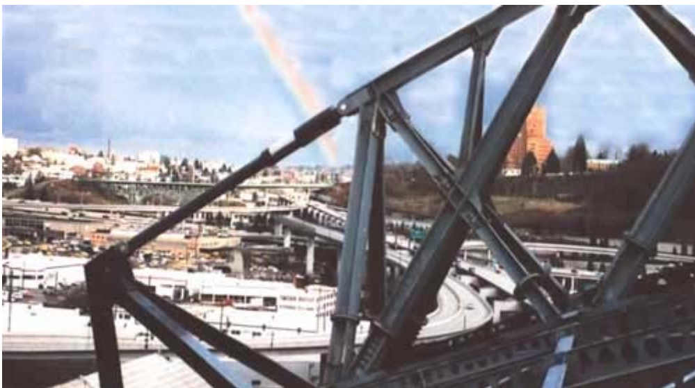
圖 1.2 西雅圖水手隊主場 Safeco Field 活動式屋頂之減震系統【4】
