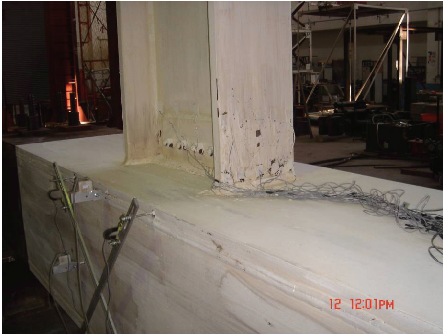
圖 4.38 試體 UN2 下翼板兩側接柱面之全滲透鐳道附近呈現微量石灰脫落 (1% drift)
