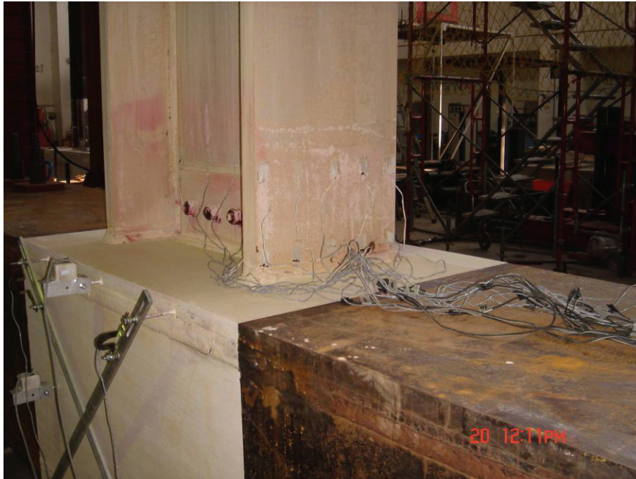
圖 4.22 試體 UN1 下翼板兩側接柱面之全滲透鉚道附近呈現微量石 灰脫落 (1% drift)
