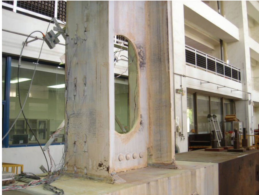
圖 4.57 試體 OP1 於下翼板及上翼板內側出現 45 度方向之石灰紋路剝落，並由兩側貫穿至翼板中心 (2% drift)
