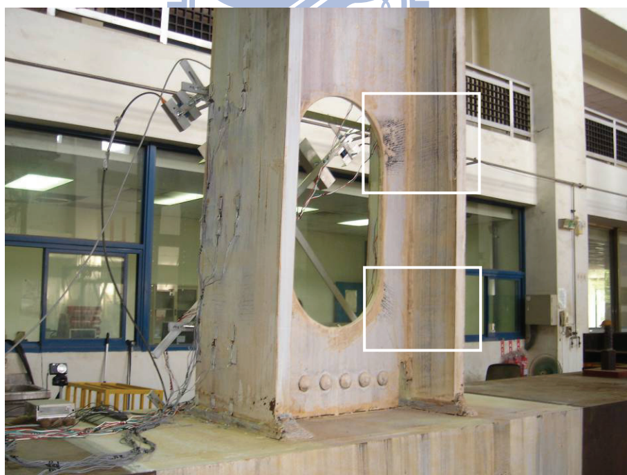
圖 4.56 試體 OP1 於上、下翼板內側接近開孔角隅處出現平行柱面之石灰剝落紋路 (1.5% drift)
