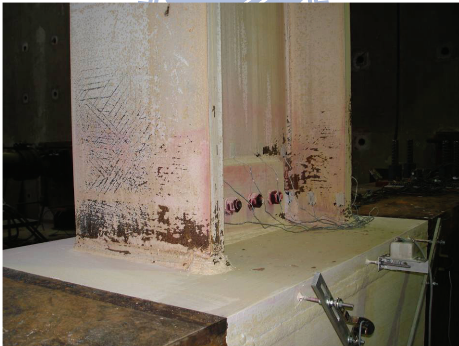
圖 4.29 試體 UN1 梁翼板出現大量且明顯之剝落並從兩側貫穿至翼 板中心 (3% drift)
