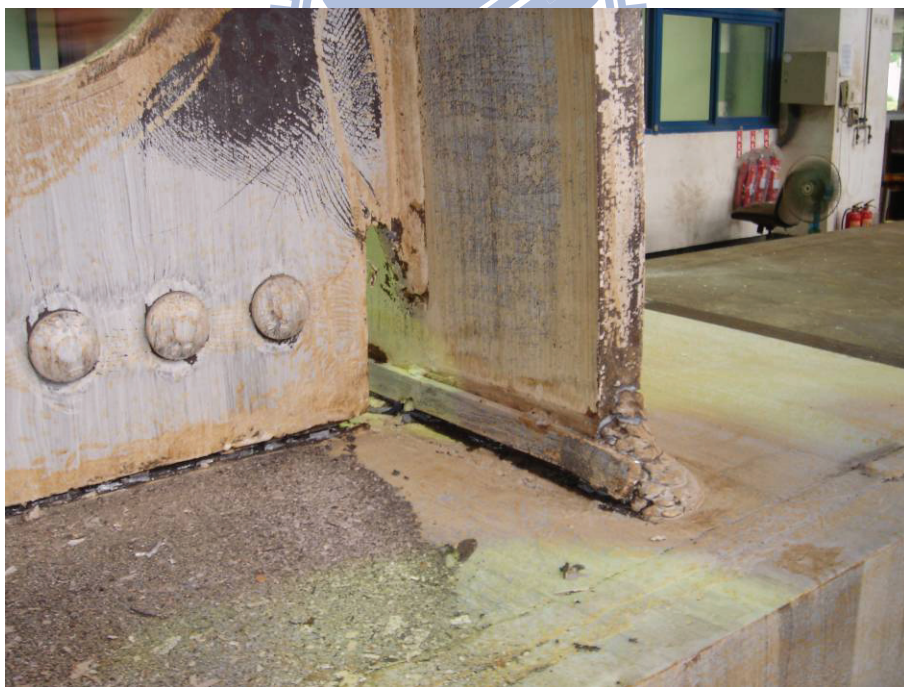
圖 4.64 試體 OP1 於上翼板全滲透鐸道處發生撕裂破壞 (4% drift)
