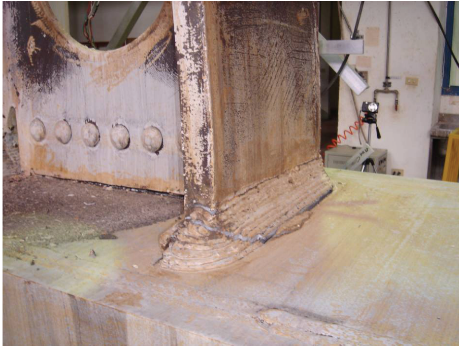
圖 4.63 試體 OP1 於上翼板全滲透鐸道處發生撕裂破壞 (4% drift)
