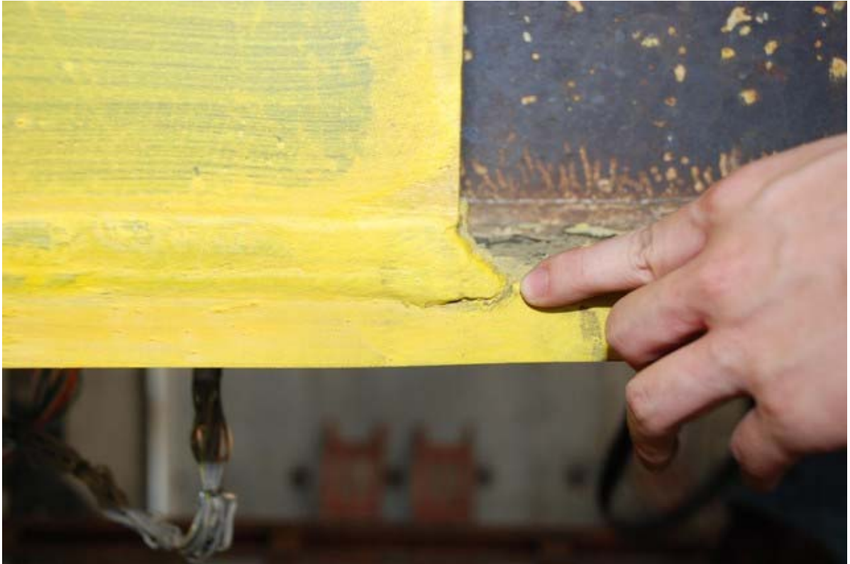
照片 3.51 試體 IFS1 加勁板端部與下翼板接合處開裂 ( \theta=4\% 弧度結束)
