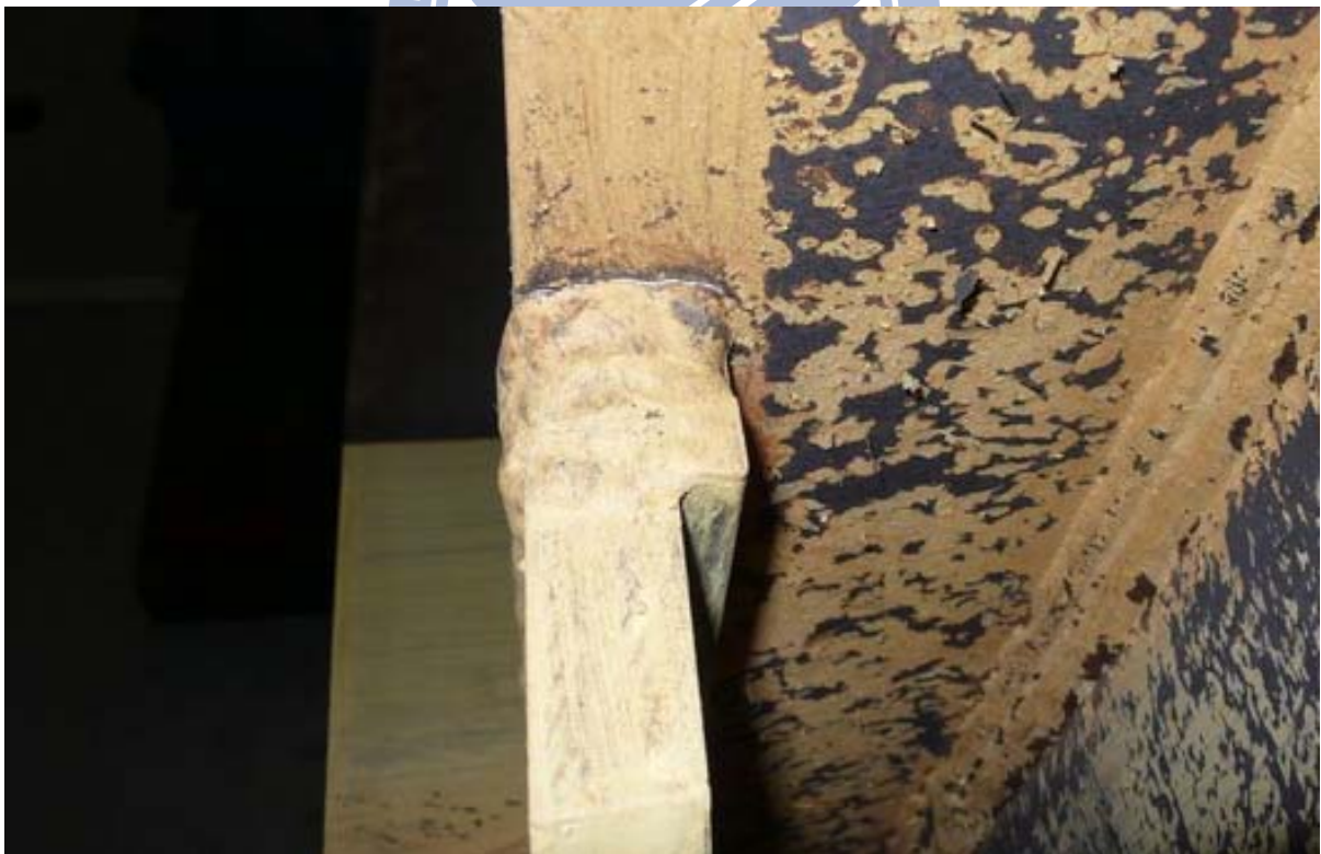
照片 3.72 試體 IFS2 加勁板端部與翼板接合處開裂 ( \theta = 4\% 弧度結束)
