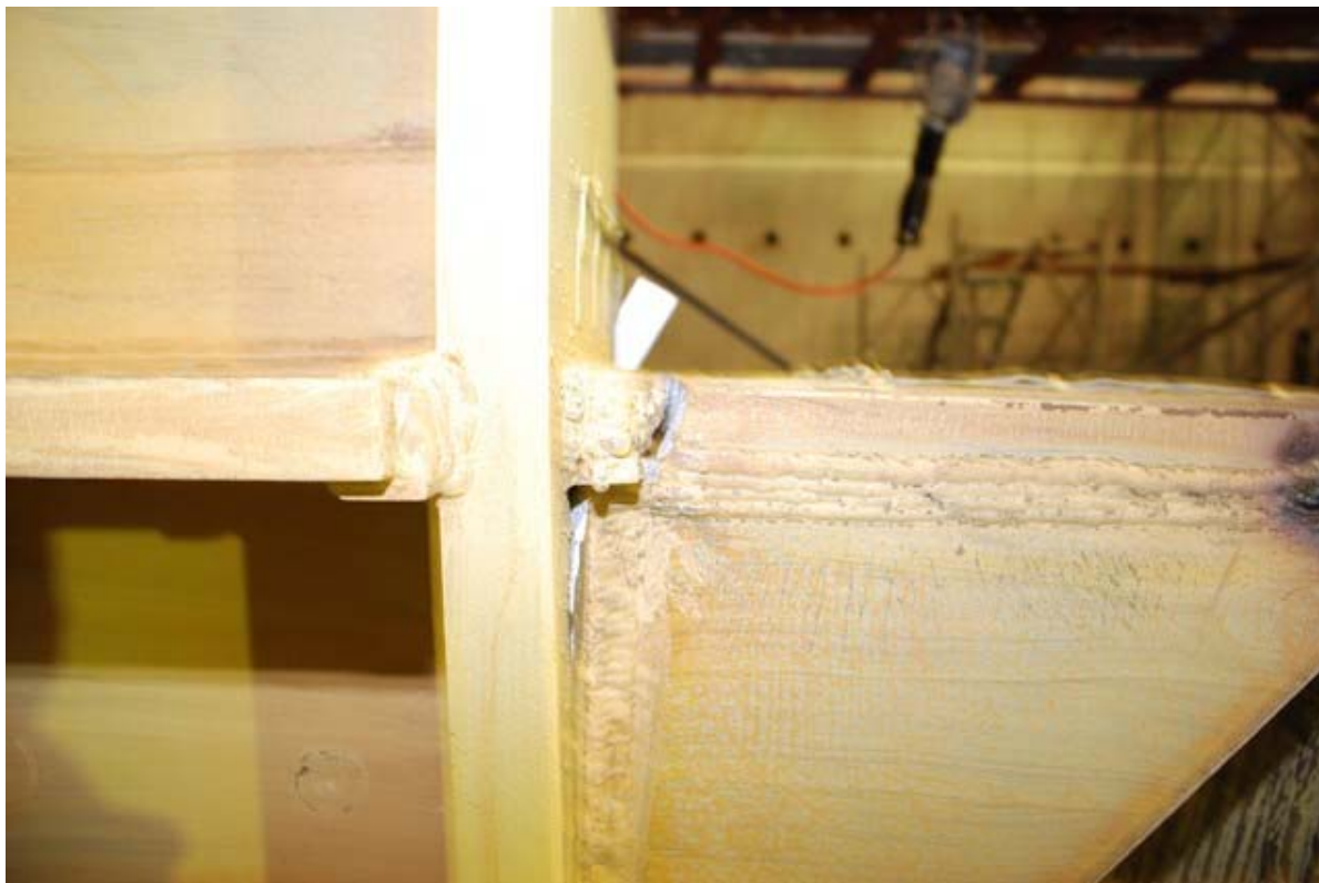
照片 3.83 試體 IFS2 梁上翼板斷裂亦造成柱板開裂 ( \theta = -5\% 弧度第二圈)
