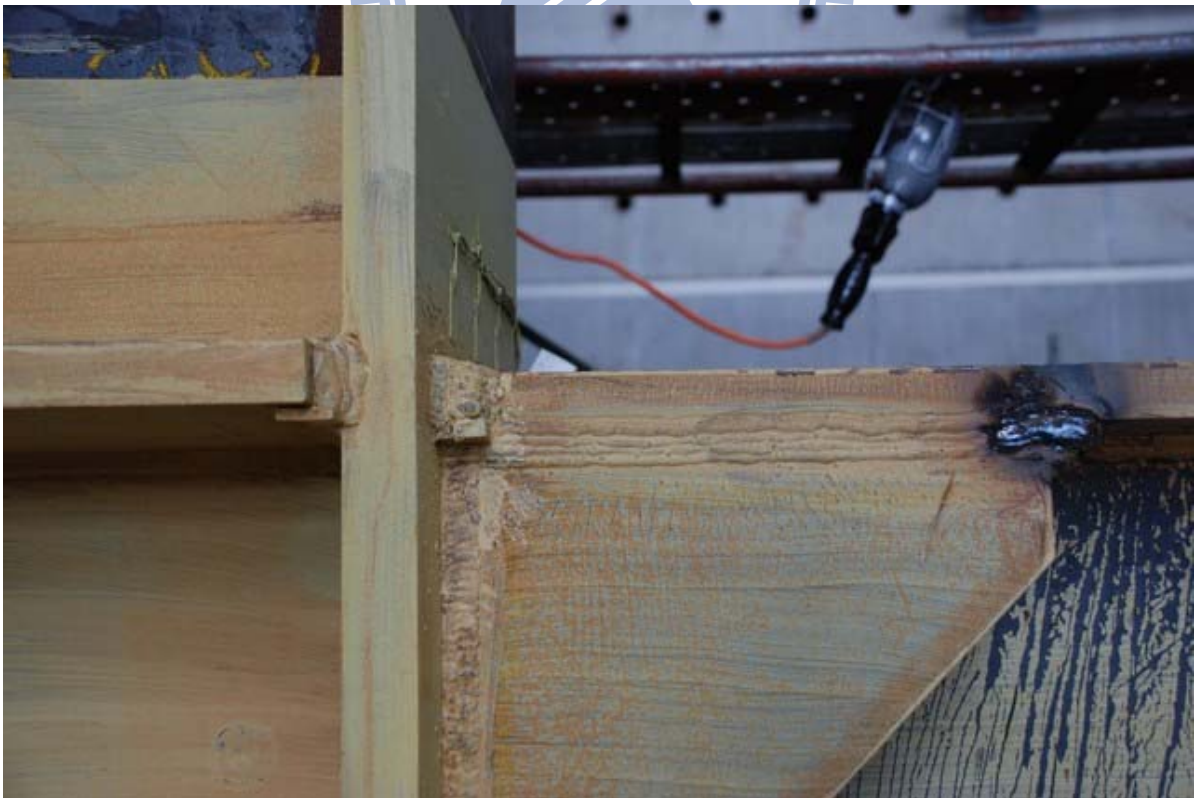
照片 3.74 試體 IFS2 第二次試驗前加勁板與梁接合之裂縫修補
