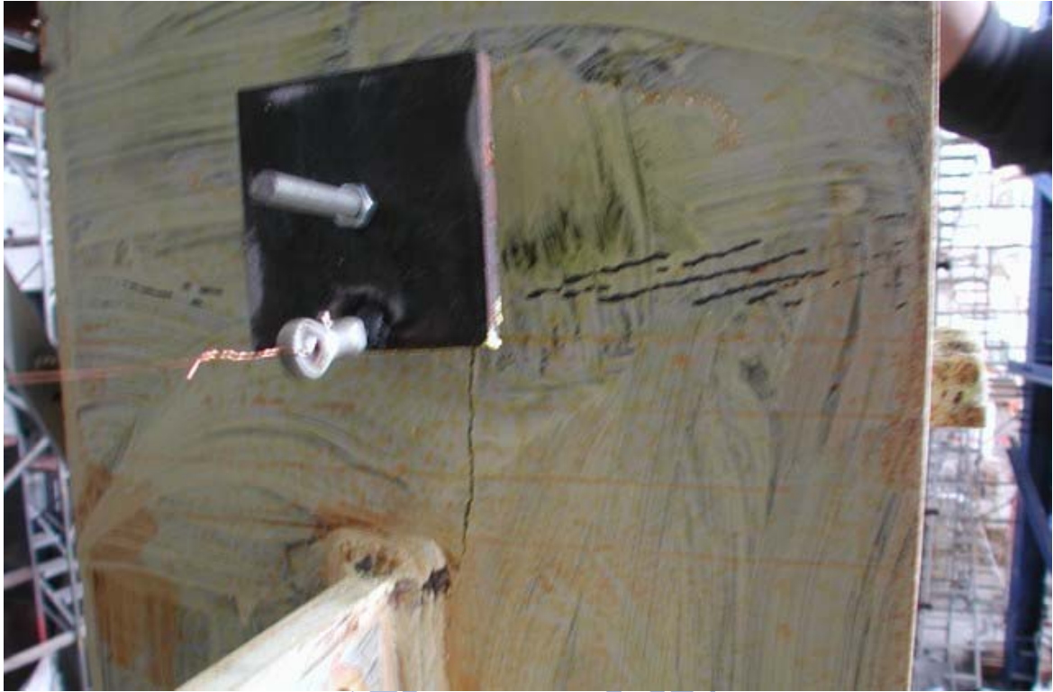
照片 3.31 試體 IFS1 背側之柱板於上橫隔板處降伏( \theta=0.75\% 弧度結束時)
