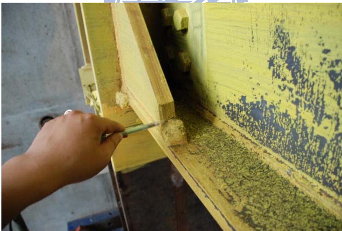
照片 3.114 試體 IFS3 加勁板焊道端部出現小裂痕 ( \theta = -3\% 弧度)
