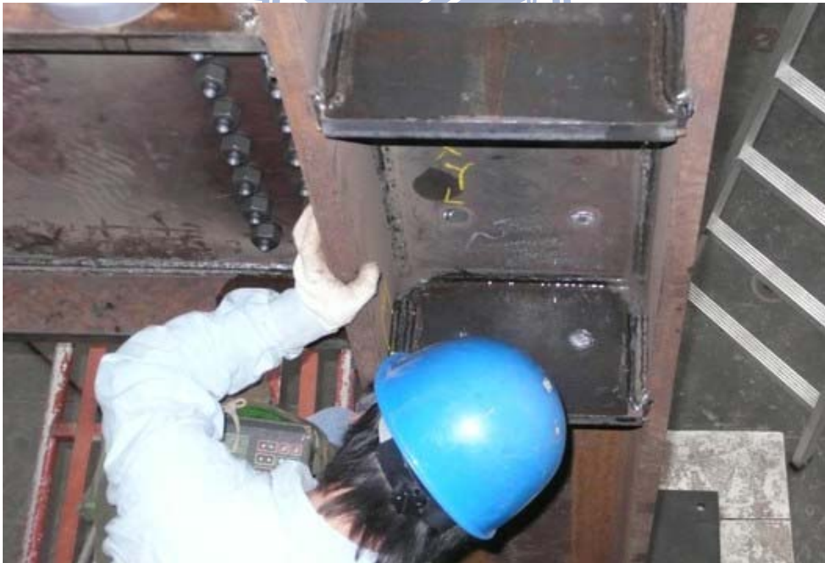
照片 3.2 試體 IFS2 交會區橫隔板焊道 UT 檢測
