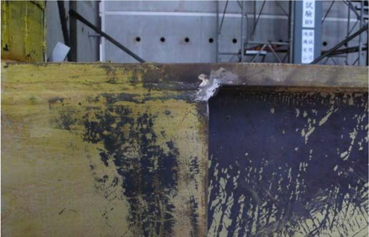
照片 3.47 試體 IFS1 第二次試驗前加勁板與梁接合之裂縫修補
