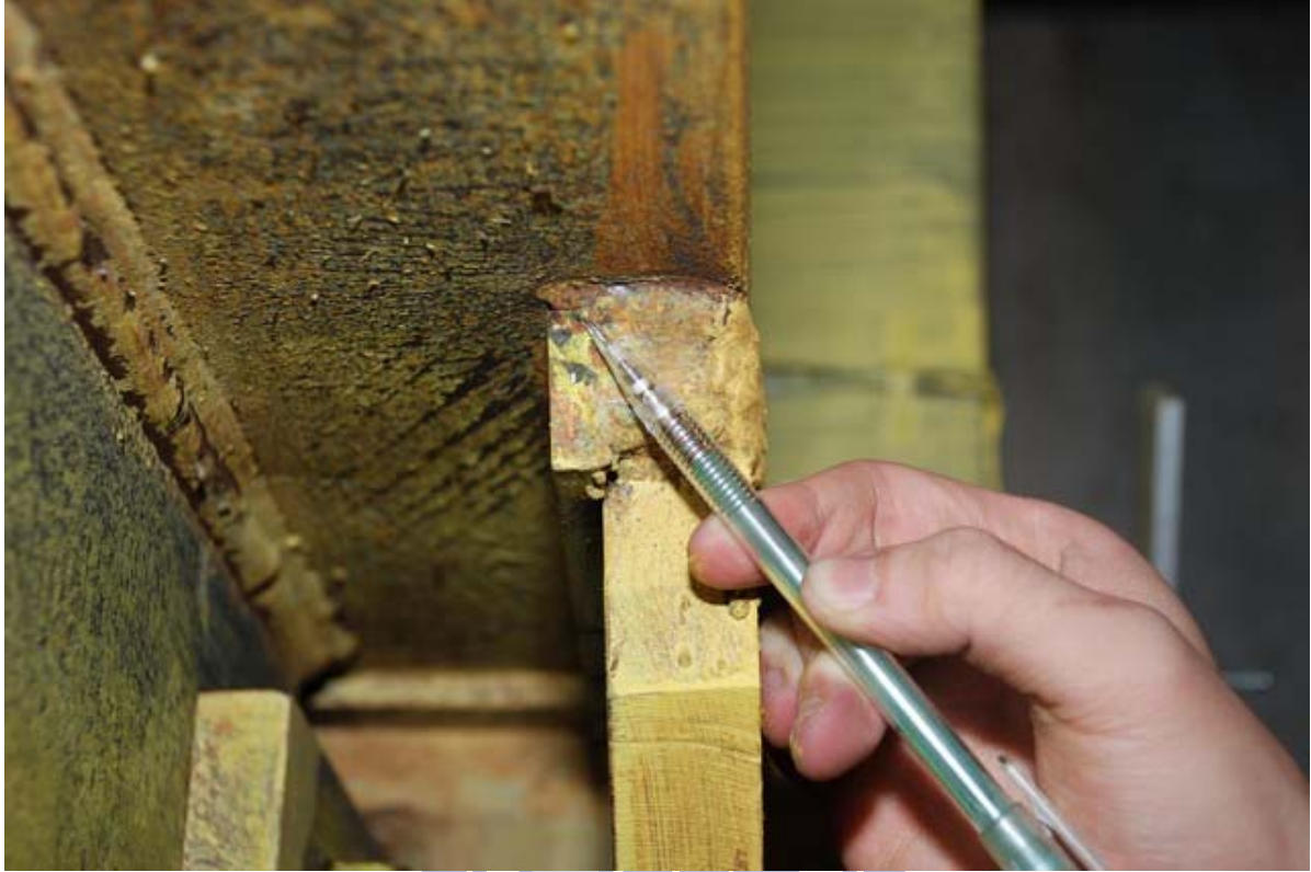
照片 3.111 試體 IFS3 加勁板焊道端部出現小裂痕 ( \theta = -1.5\% 弧度)
