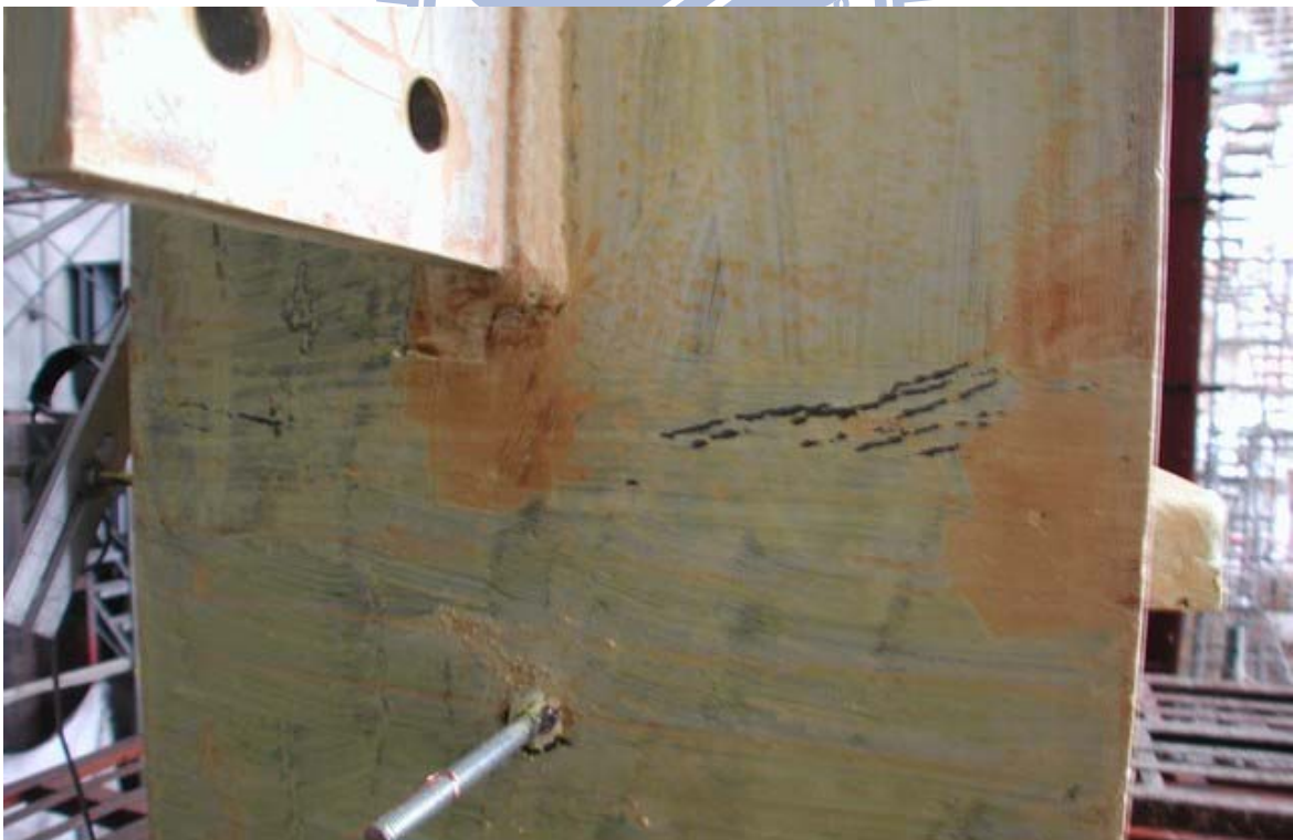
照片 3.32 試體 IFS1 背側之柱板於下橫隔板處降伏( \theta=0.75\% 弧度結束時)
