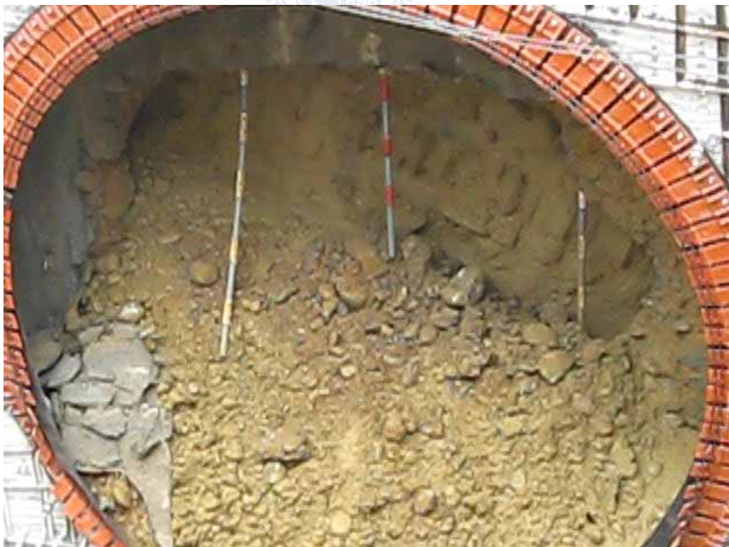
圖 5-11 潛盾機到達#6A 直井破鏡出土狀況 (介興/清水營造 2009)
