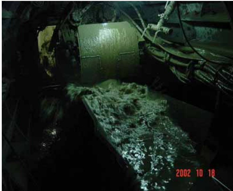
圖 4-20 一號潛盾機螺運機出土閘門開啟產生大量湧水情形 (中華顧問 2002)
