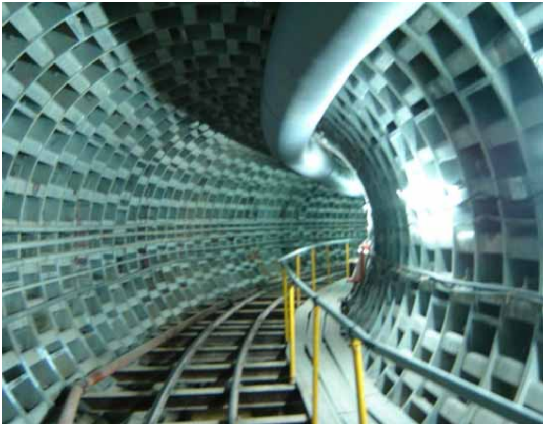
圖 5-6 急曲線潛盾隧道完工圖 (中華顧問 2004)
