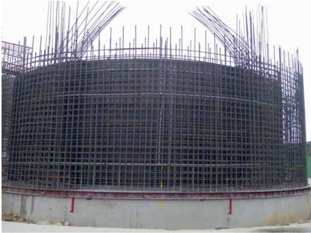
圖 5-16 沉箱主體未澆置混凝土情況 (介興/清水營造 2009)
