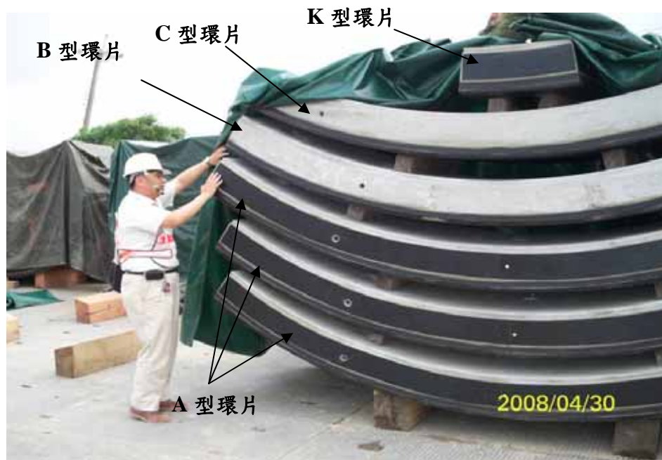
(a) 各型式鋼筋混凝土環片 (由下而上分別為 A 型、B 型、C 型與 K 型環片)
