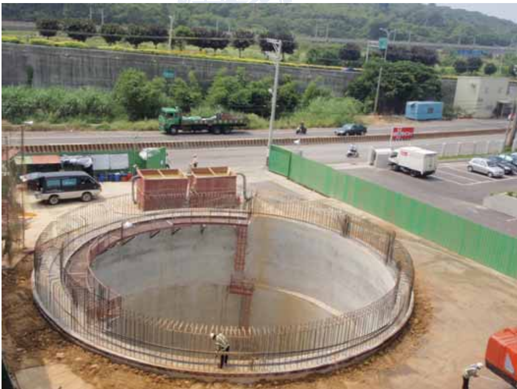
圖 5-17 沉箱主體（工作井）完成圖 (介興/清水營造 2009)
