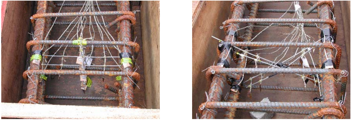
圖 21 熱電偶佈設現況
