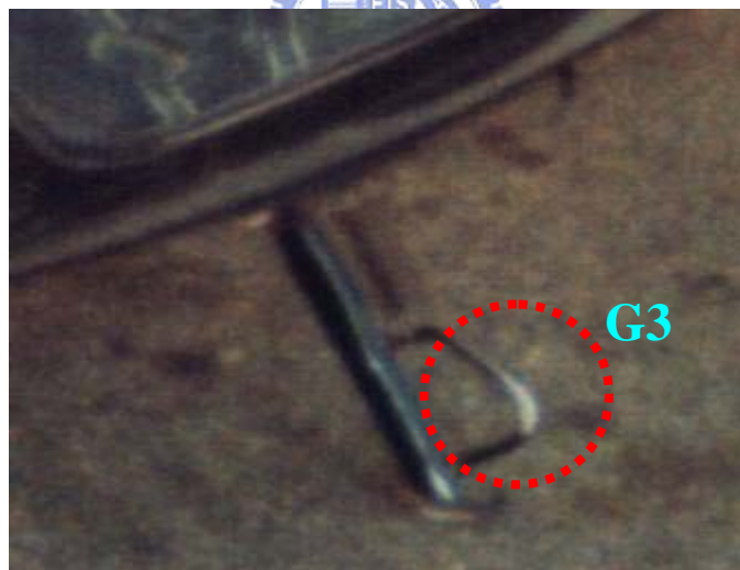
A 車省力車架受損情形
