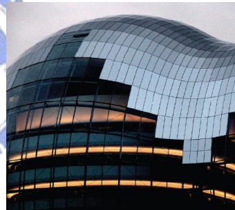
圖 2-21 Sag 流行音樂中心外皮四邊平面玻璃
