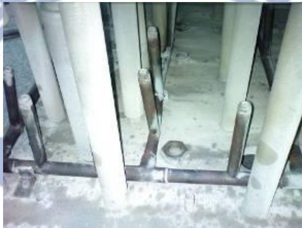
圖 2.15 冷卻水銅管
