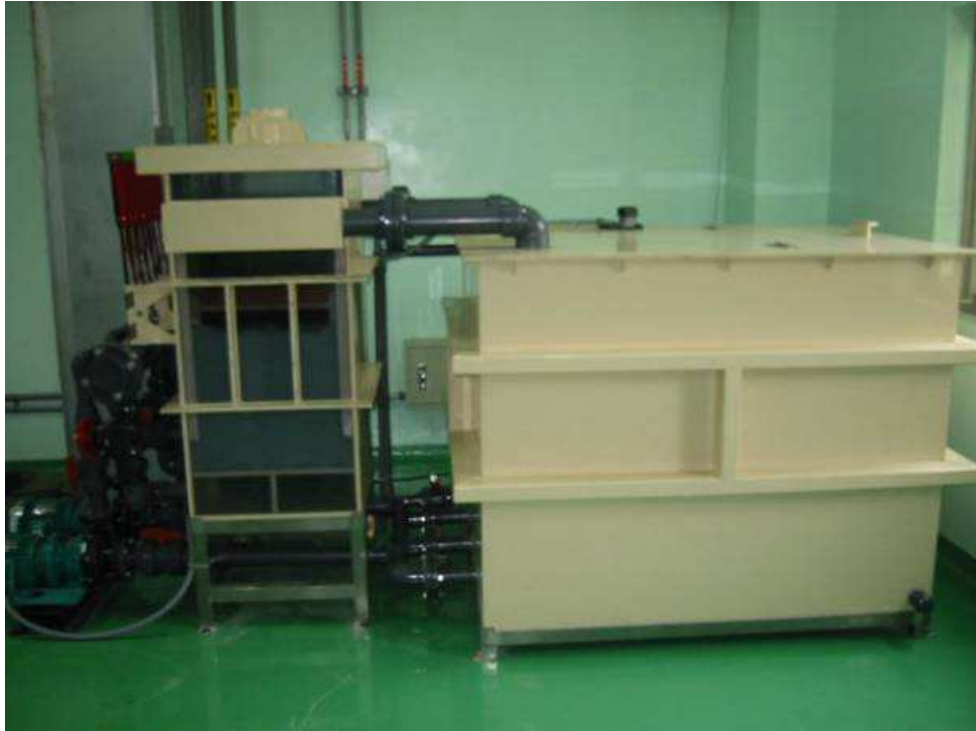
圖 2-9 流體化床式電解設備
