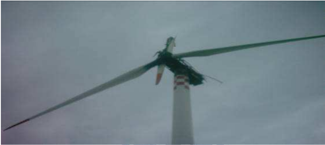
圖3-9. 2號風力發電機燒損的情況
