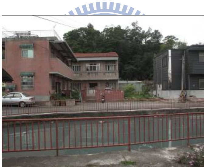
圖 1-3-3-3 震後重建單邊護龍的林連伙房(林姐家)，正廳改為二樓。
