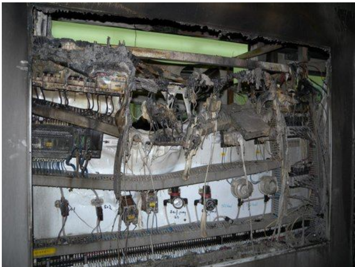
圖 1-7 MEMS 微機電系統廠無塵室濕式晶圓清洗機起火[19]
