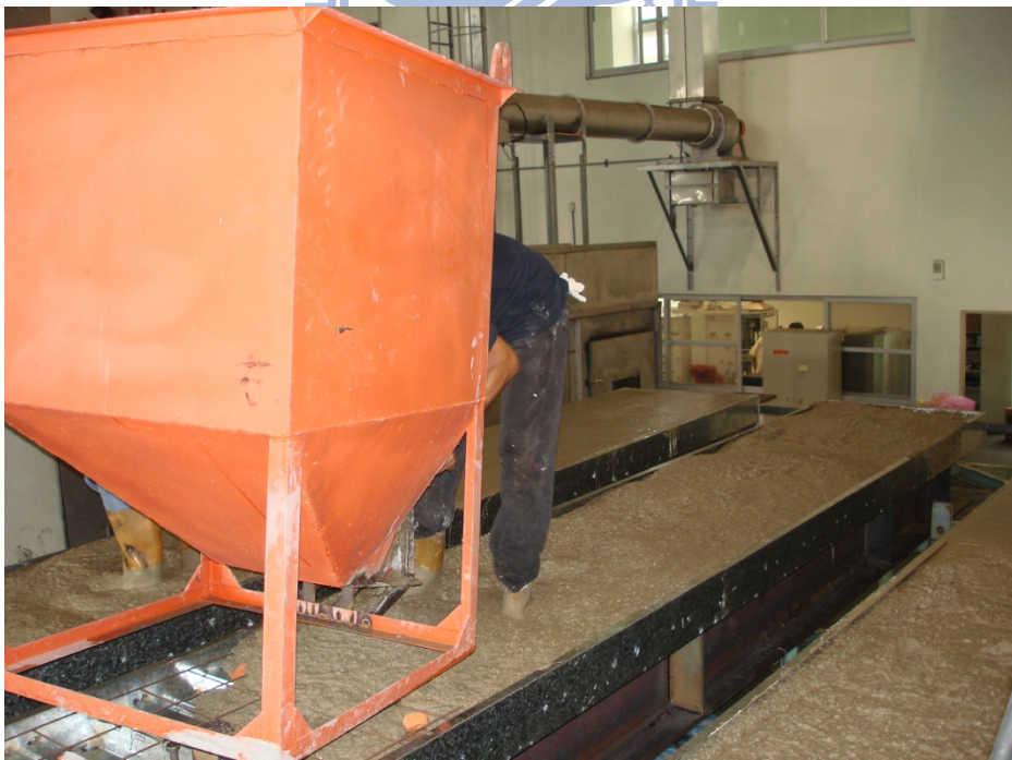
圖 3-2 試體樓板混凝土澆注施工
