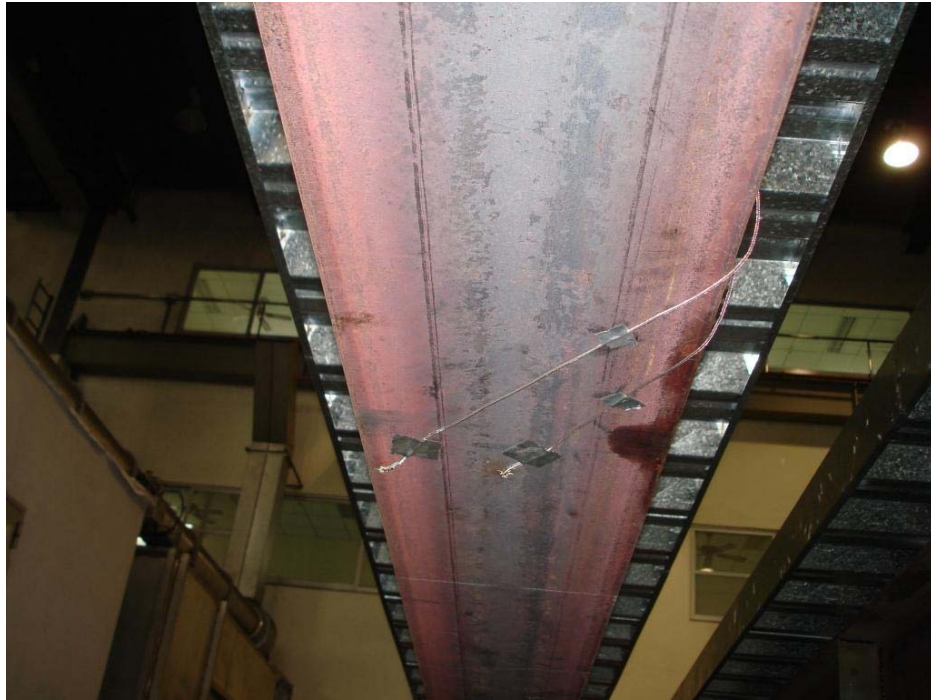
圖 3-5 鋼梁下翼板熱電偶線設置
