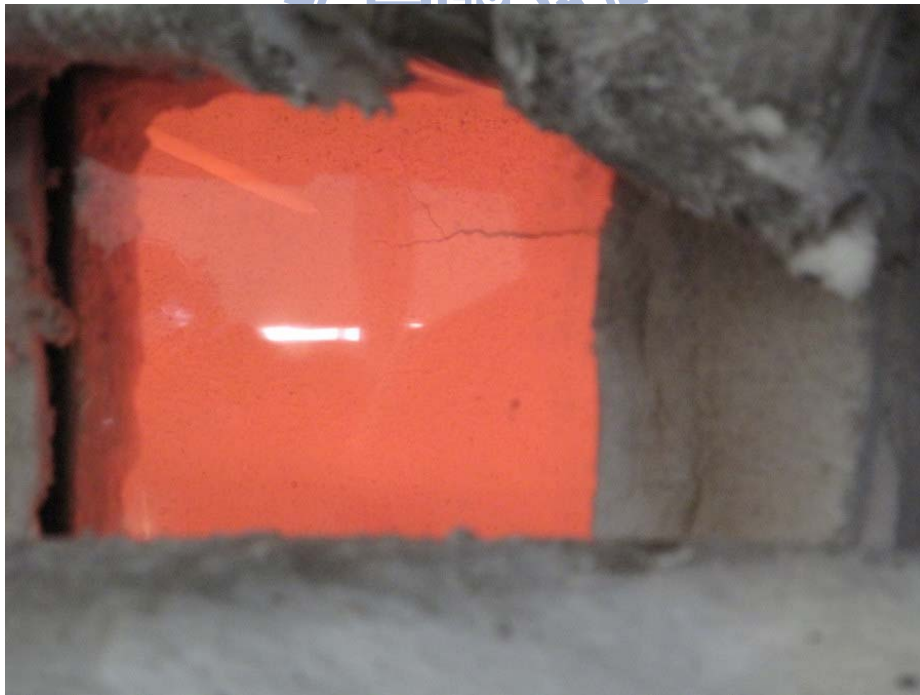
圖 3-47 試體 2 試驗時裂縫出現情況
