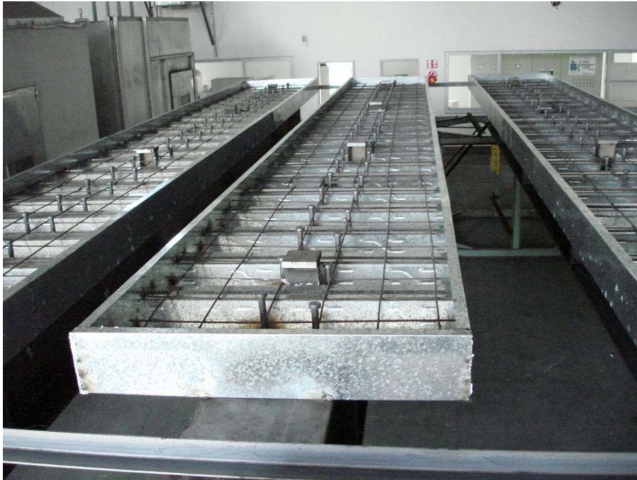
圖 3-1 試體之鋼承板、剪力釘、鋼絲網設置
