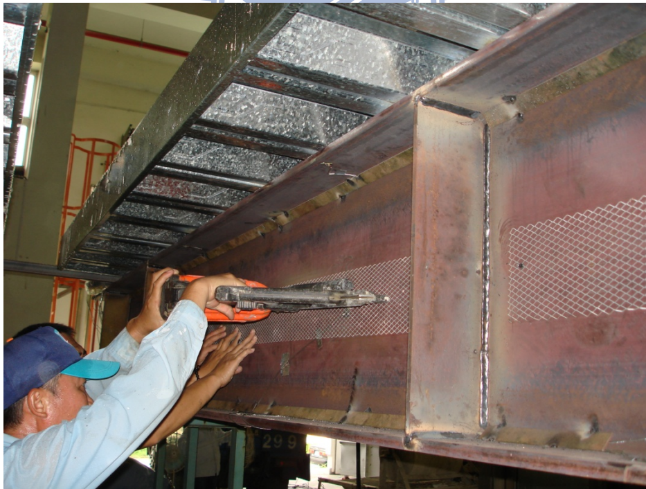
圖 3-6 鋼梁鋼網施工
