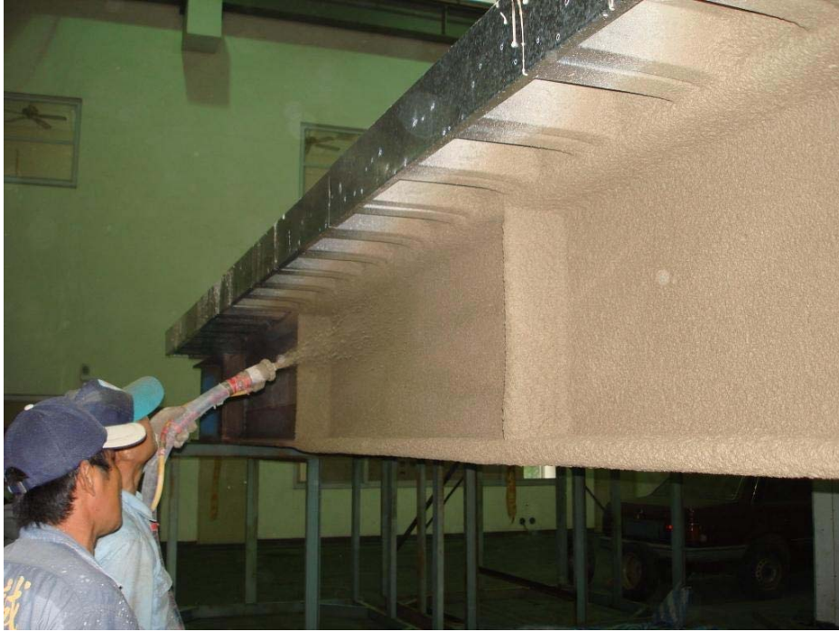
圖 3-7 鋼梁防火被覆施工 (一)
