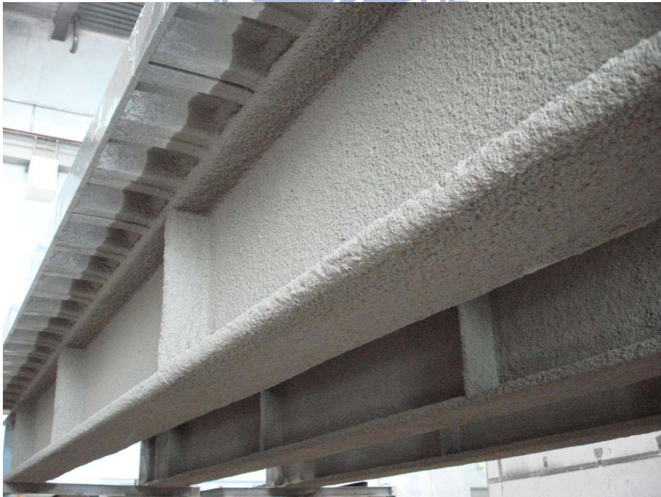
圖 3-10 鋼梁防火被覆完成施工
