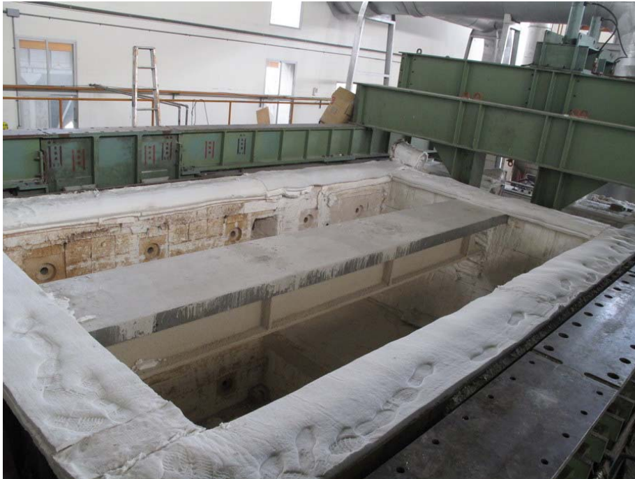
圖 3-15 試體安裝於加溫爐內情況
