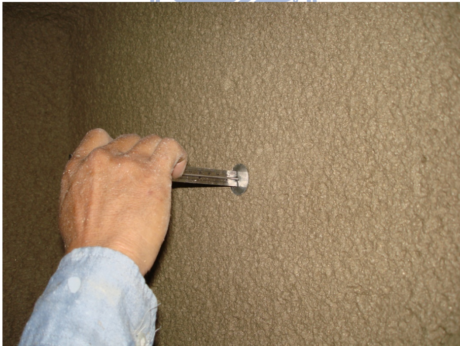
圖 3-8 鋼梁防火被覆施工 (二)
