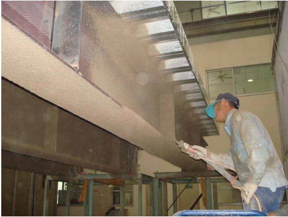
圖 3-9 鋼梁防火被覆施工 (三)
