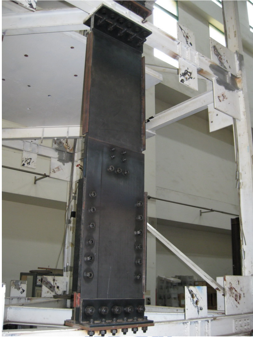
圖 4.18 摩擦制震壁組裝完成照片
