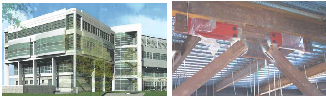
圖 1.12 Ambulatory Care Center 及摩擦阻尼器施工安裝照片【9】
