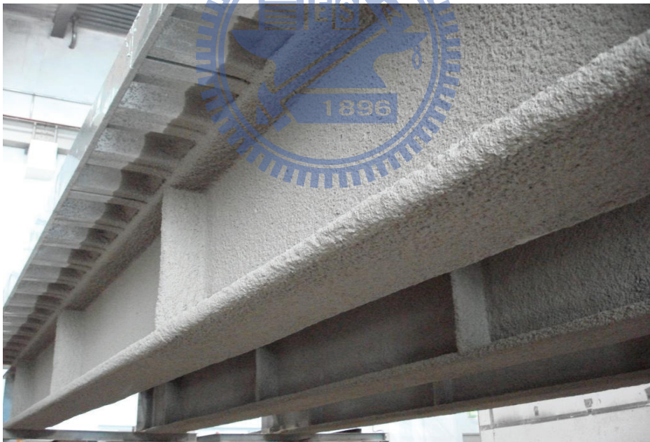
圖 4-5 防火被覆施工完成 (趙文成與陳誠直 2009)
