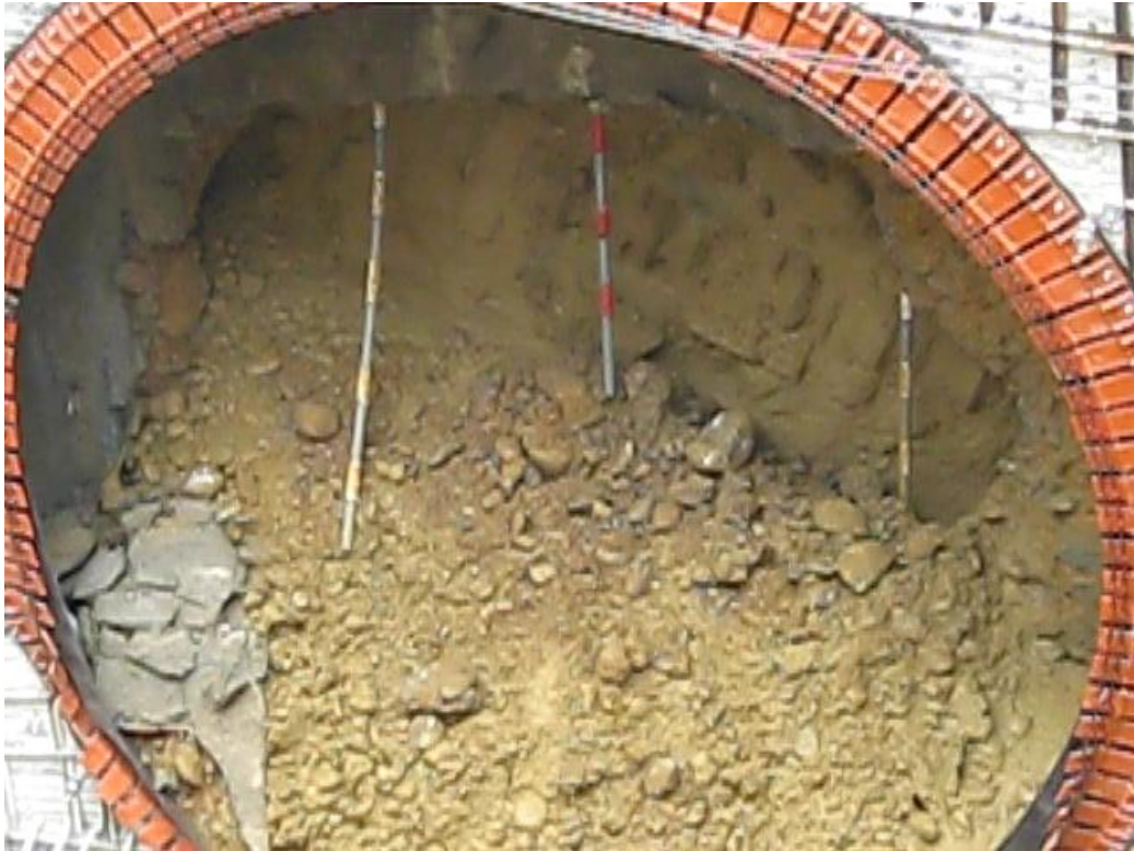
圖 3-4 潛盾機到達#6A 直井破鏡出土狀況 (介興/清水營造 2009)
