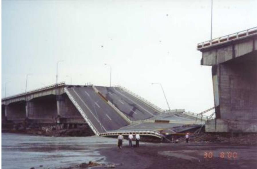
圖 1.1-1 高屏大橋 2000 年 8 月斷橋情形
