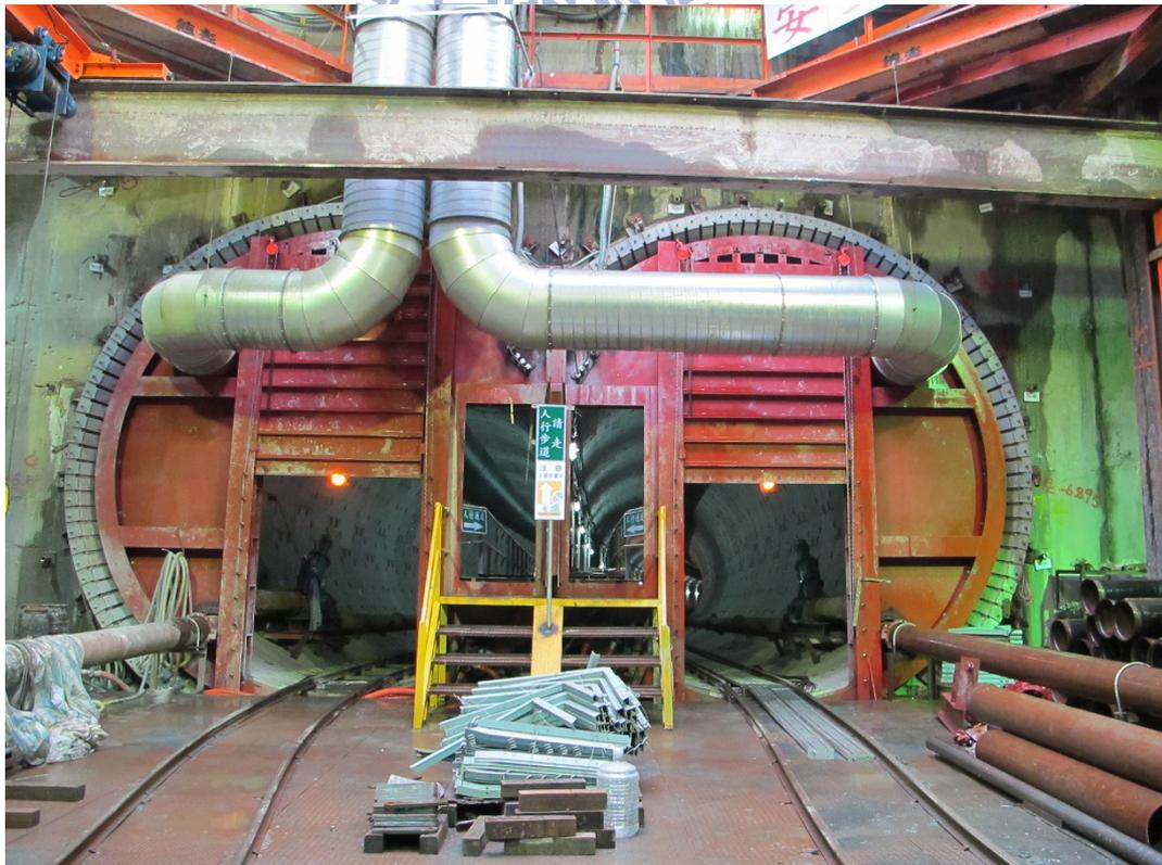
圖 4-2 桃園機場聯外捷運 CA450A 標 DOT 潛盾隧道出發端隧道口
