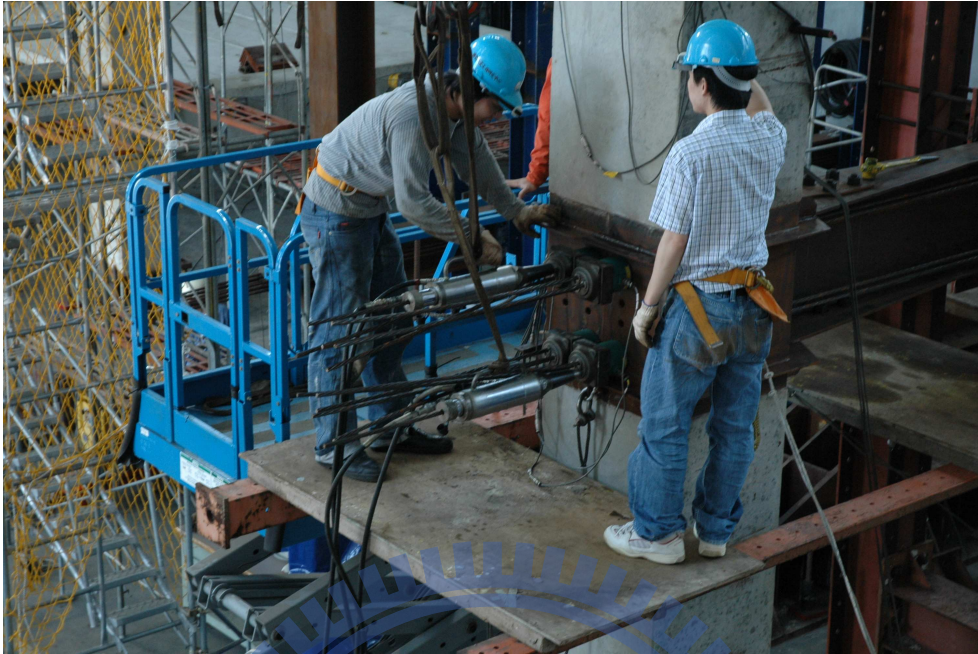
照片 3.8 施加預力連接梁柱
