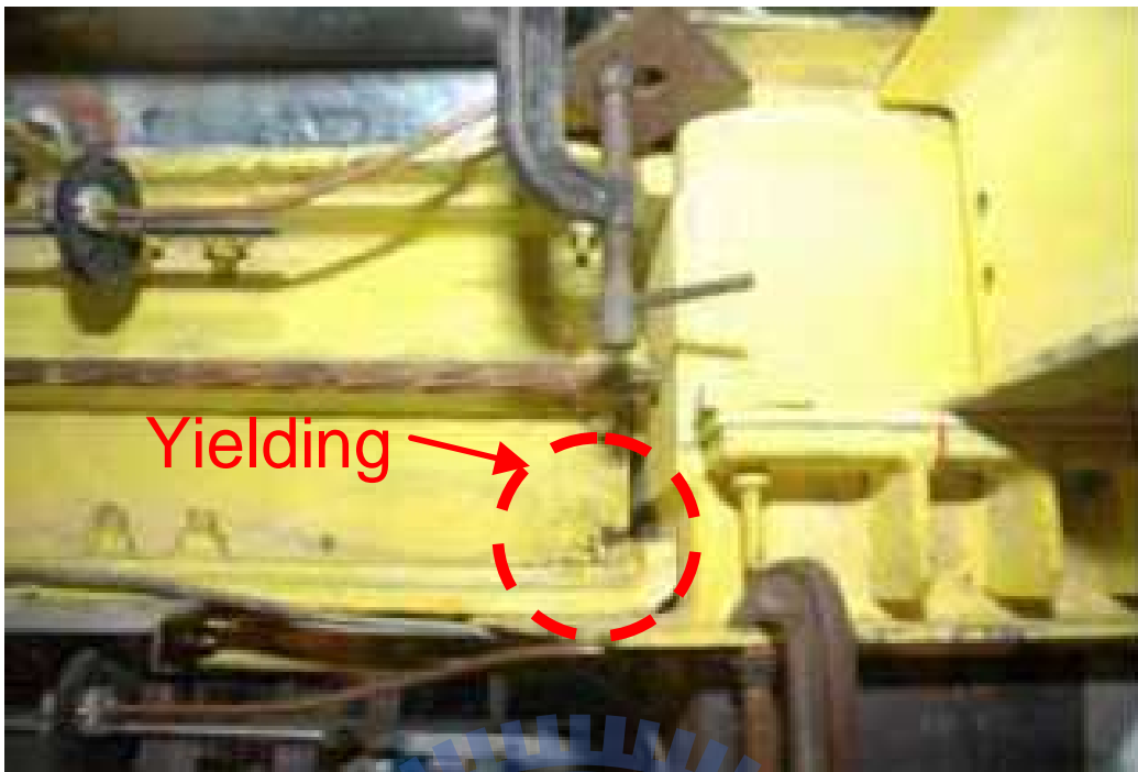
照片 4.4 梁腹板降伏 (第 1 階段第 7 次試驗)
