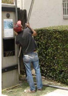
Figure 23 安裝支撐鋼柱
