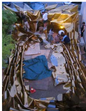
Figure 27 安裝表皮至框架
