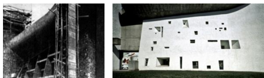
圖 34 混凝土構築方式讓牆面上具有大小不一的開口。
