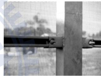
溫室的結構主要使用C型鋼及圓管，由於溫室置於室外，為提高使用年限，防止鏽蝕，結構都先經過模矩化，制定好各種元件的尺寸，以方便在工廠先製作，製作之後經熱浸鍍鋅處理；在施工現場不做任何焊接工作，以螺絲相互鎖固。
