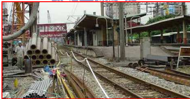
圖 25 緊鄰行車空間堆放物品圖
