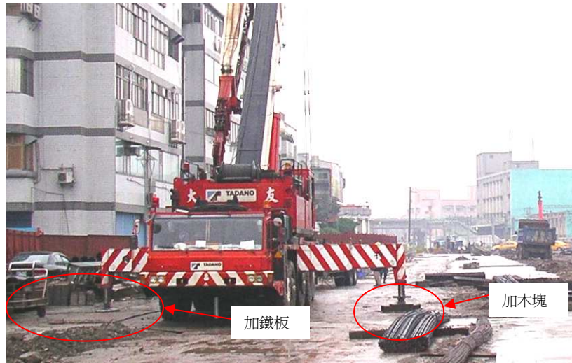
圖 62 吊掛支點加強圖
