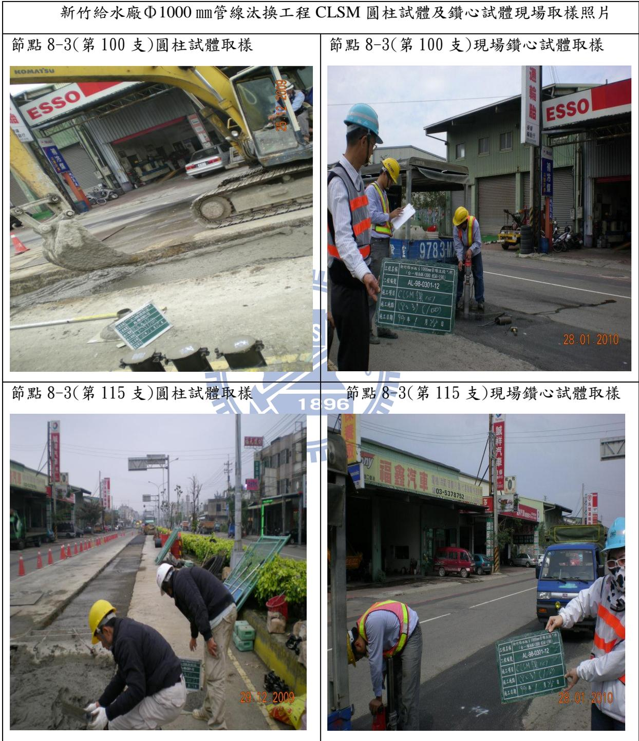
圖 4-6 新竹給水廠  $\Phi 1000$  mm 管線汰換工程 CLSM 圓柱及鑽心試體取樣
