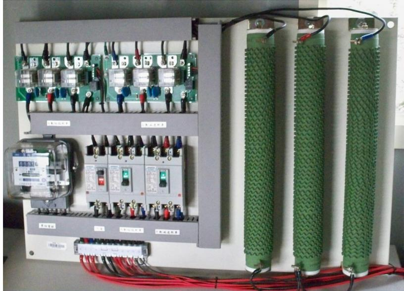
圖 2-10 小型風力發電系統剎車裝置
