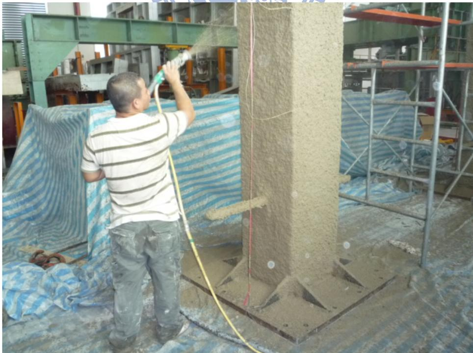
圖 3-10 CFBC 試體防火被覆施工(二)
