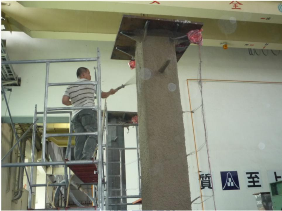
圖 3-9 CFBC 試體防火被覆施工(一)
