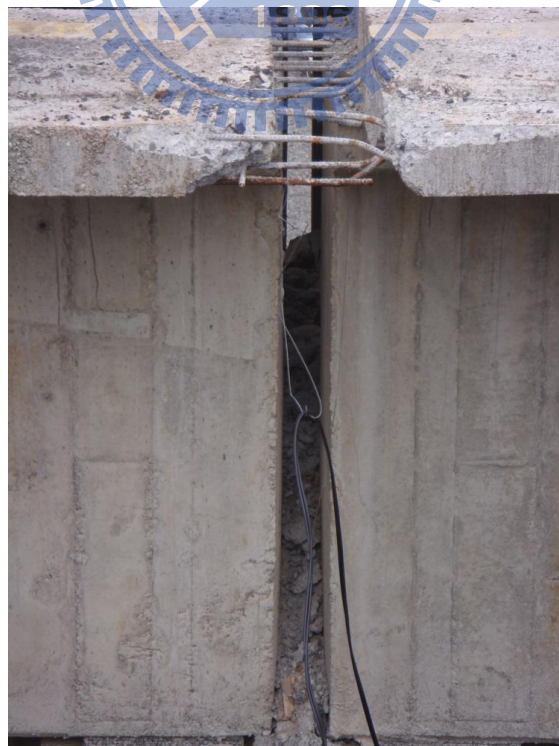
圖 2.6 橋面板連續 AC 磨耗層切割狀態
