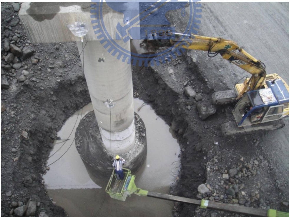
圖 2.24 衝擊試驗裸露四米現地照片
