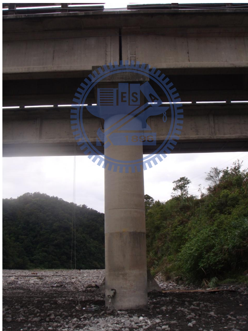
圖 2.12 微動試驗 (二) 未裸露現地照片
