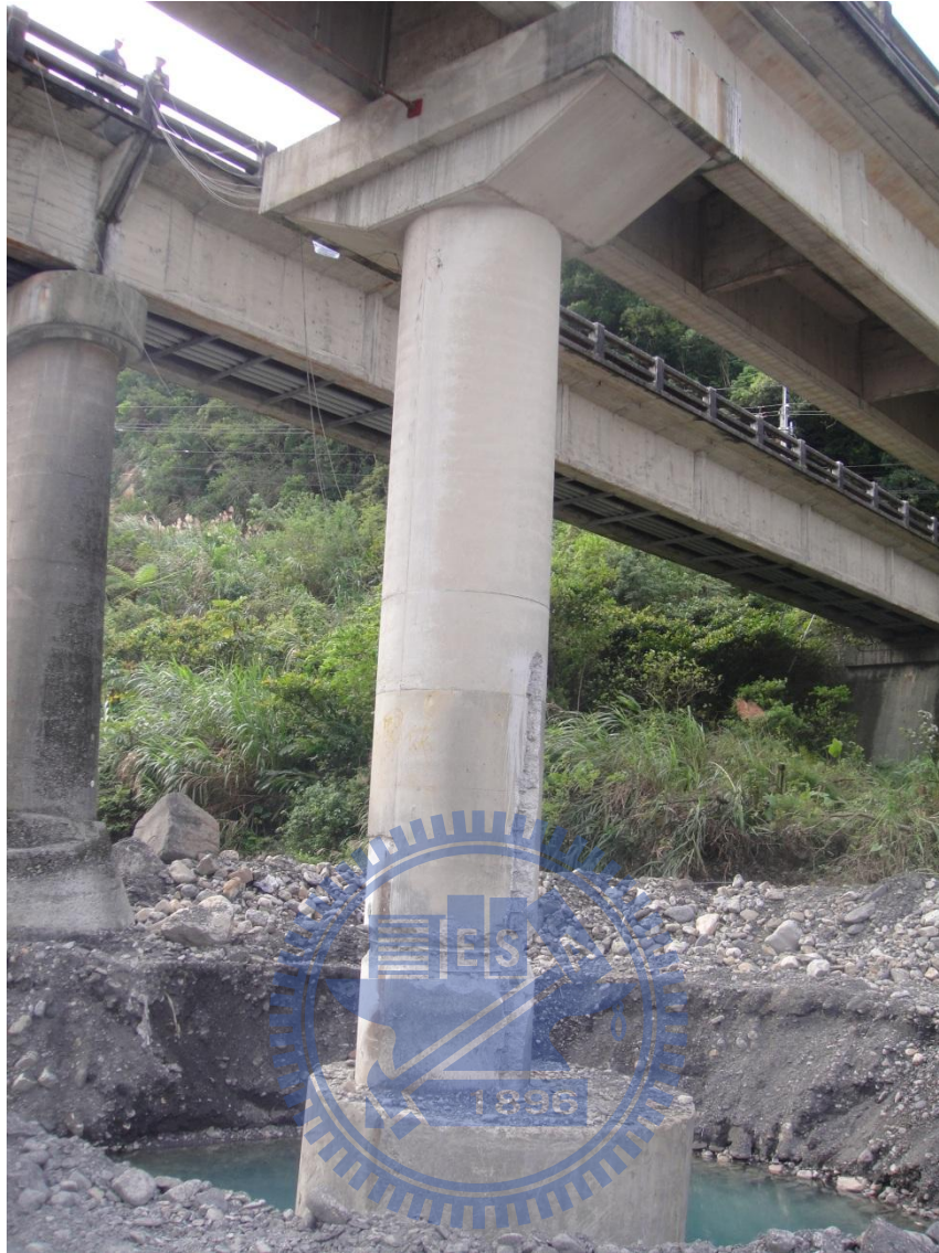
圖 2.17 自由衰減試驗裸露四米現地照片
