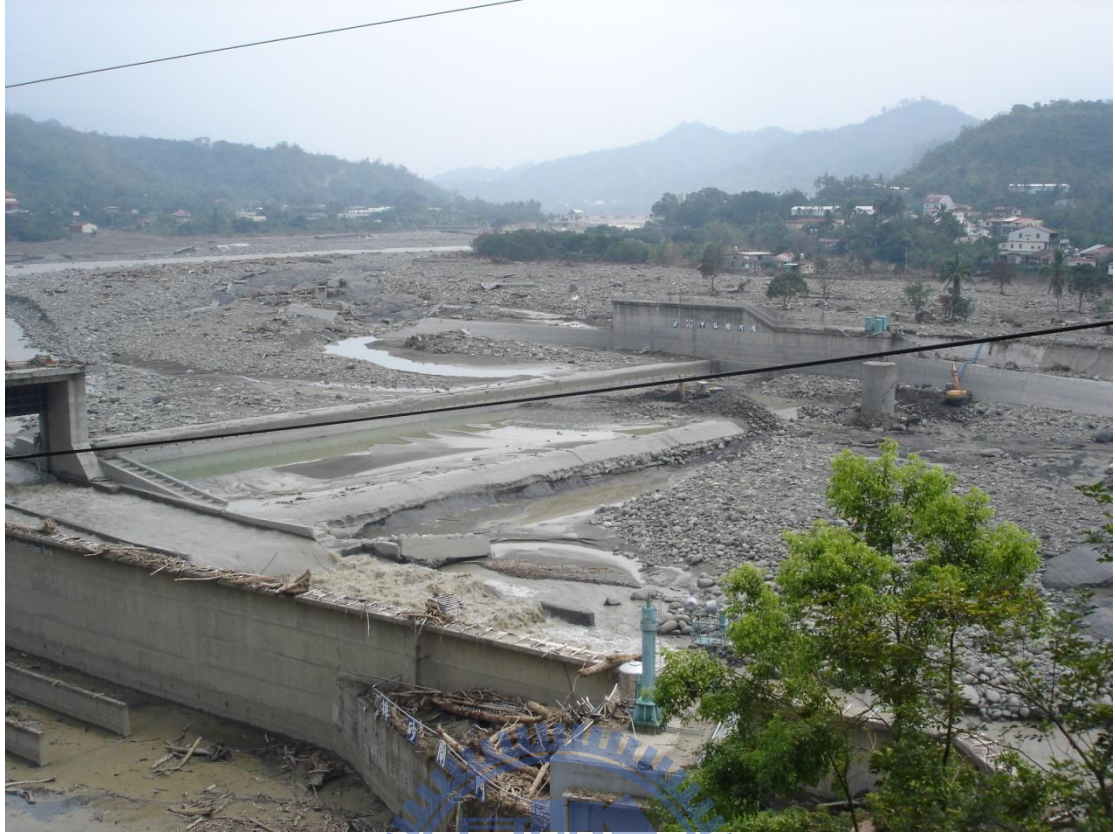
圖 4- 26 甲仙攔河堰下游沖刷坑(攝於 20090822)
