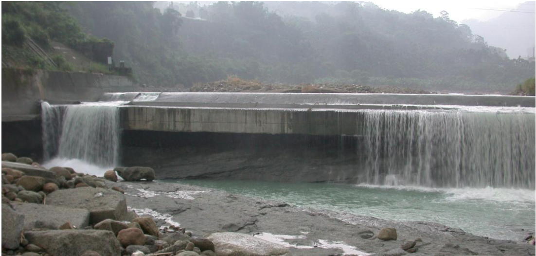
圖 3- 10 觸口堰下游沖刷情況(20050729)
