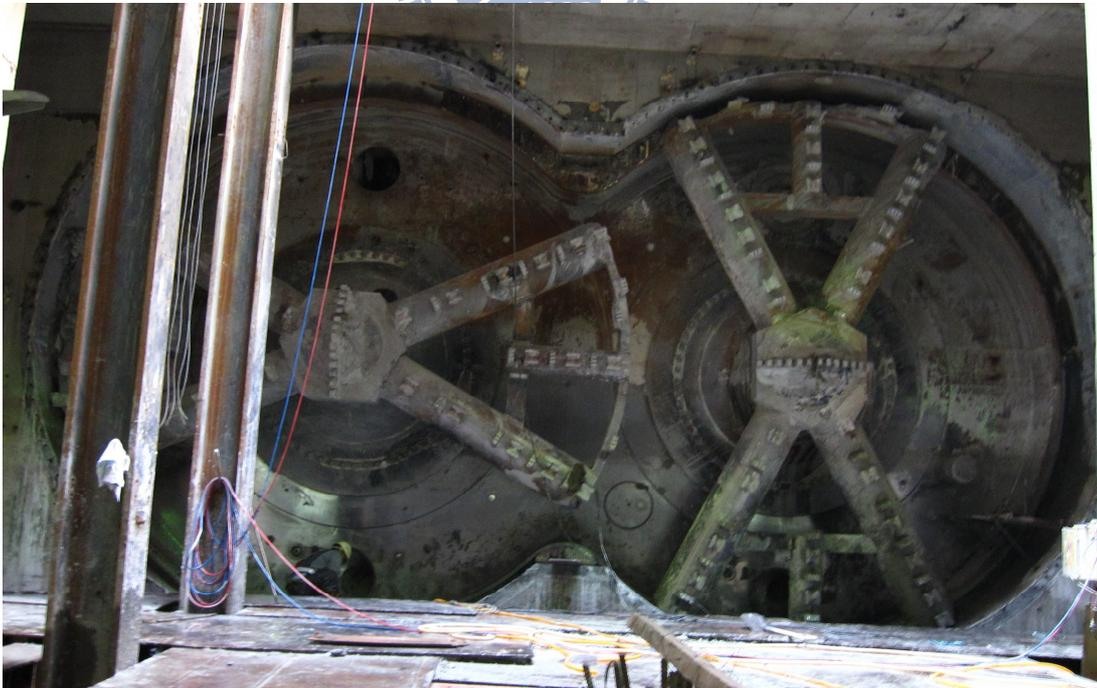
圖 4-27 CA450A 標 DOT 潛盾隧道到達端隧道口
