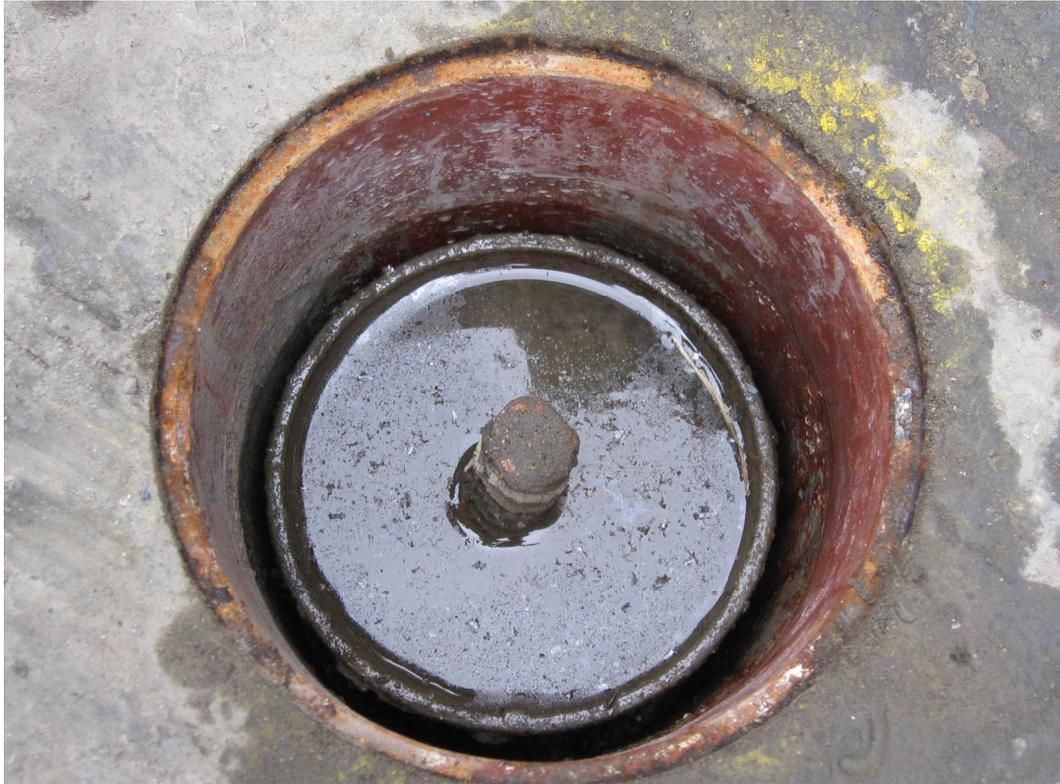
圖 4-22 CA450A 標淺式地表沉陷觀測點 (SSI)
