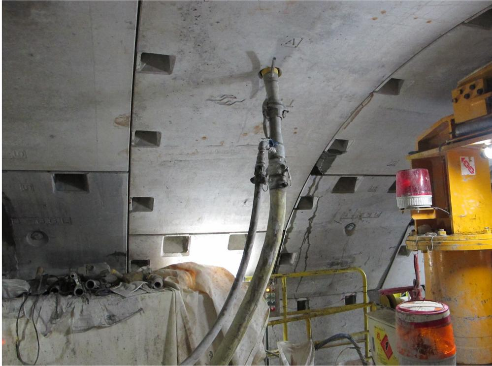
圖 4-12 CA450A 標 DOT 潛盾隧道自環片背填灌漿
