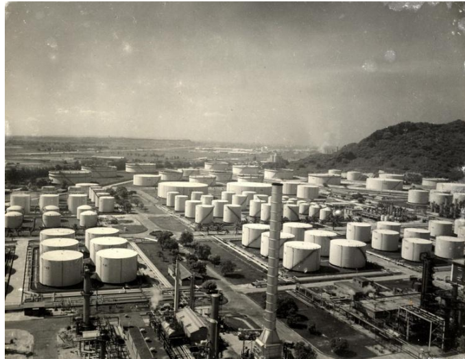
圖 2-1 位於地面油槽(台灣工業文化資產網，2009)
