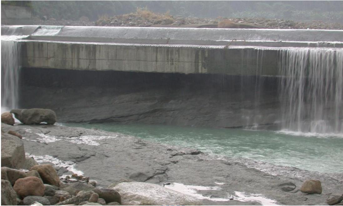
圖 2—27 觸口攔河堰堰底因岩床均勻下切掏空(2005)
