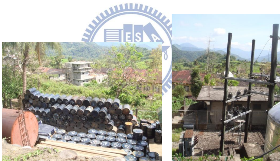
左圖4-2：Lubuagan鎮發電站廠區所堆存的燃料桶。
