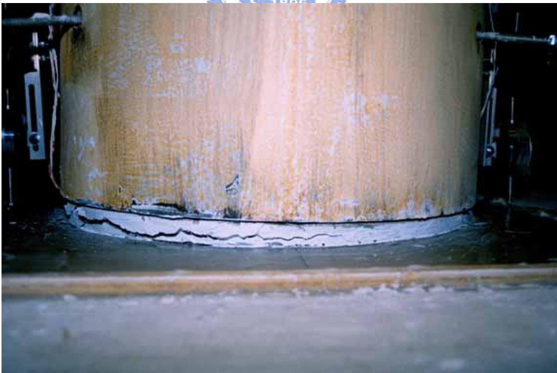
照片 3.26 試體 SP1 柱底部混凝土裂縫長度 ( \theta = +0.03 弧度)
