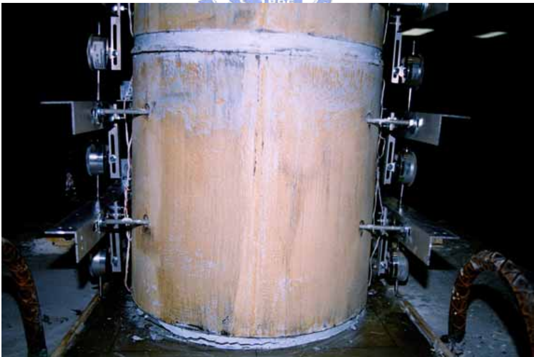
照片 3.32 試體 SP1 柱底部混凝土裂縫長度 ( \theta = +0.04 弧度)
