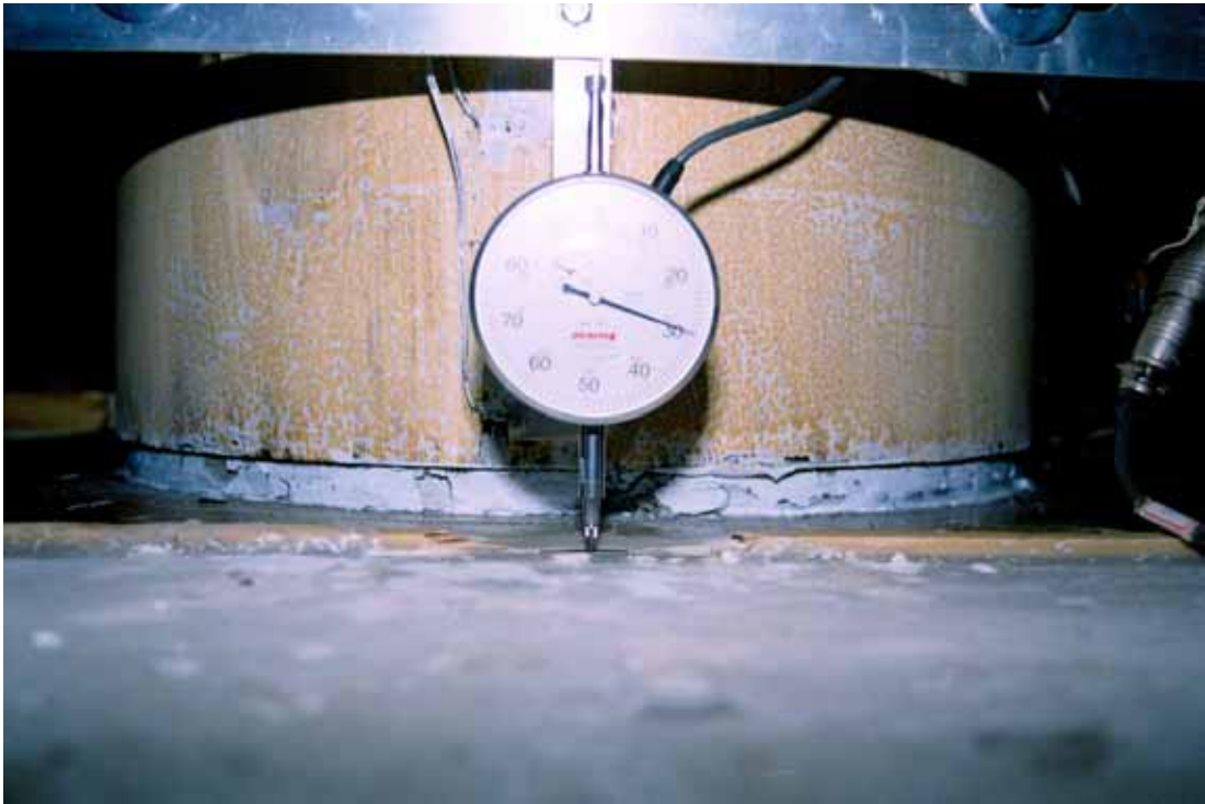
照片 3.27 試體 SP1 柱底部混凝土剝落 ( \theta = +0.03 弧度)
