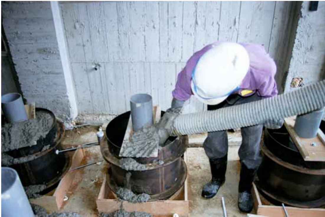
照片 3.5 節塊混凝土澆置
