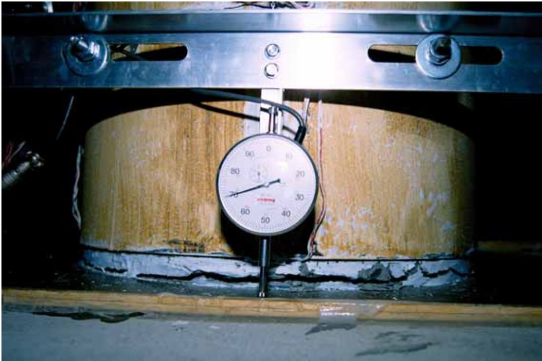
照片 3.25 試體 SP1 柱底部混凝土撓曲裂縫 ( \theta = +0.03 弧度)
