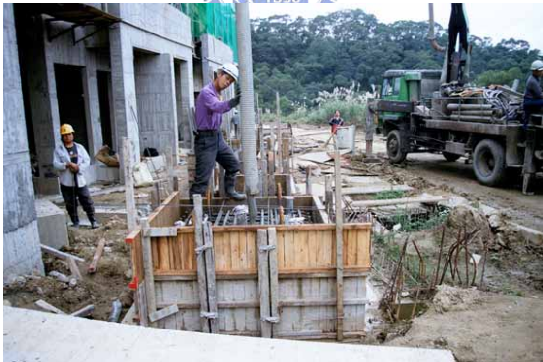
照片 3.4 基礎混凝土澆置
