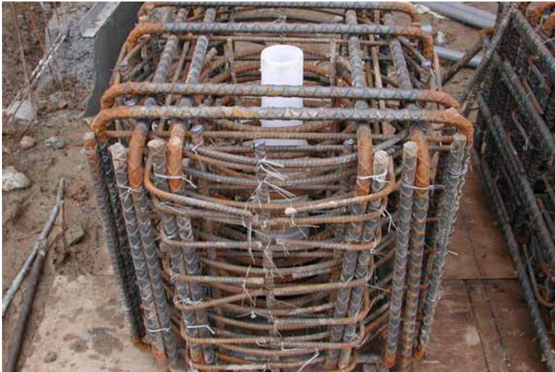
照片 3.3 橋柱頂部錨錠節塊鋼筋籠
