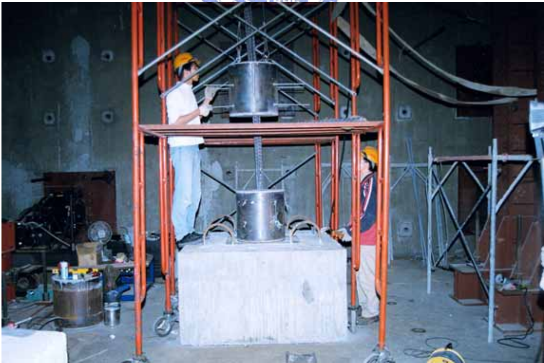
照片 3.12 第二節塊吊裝
