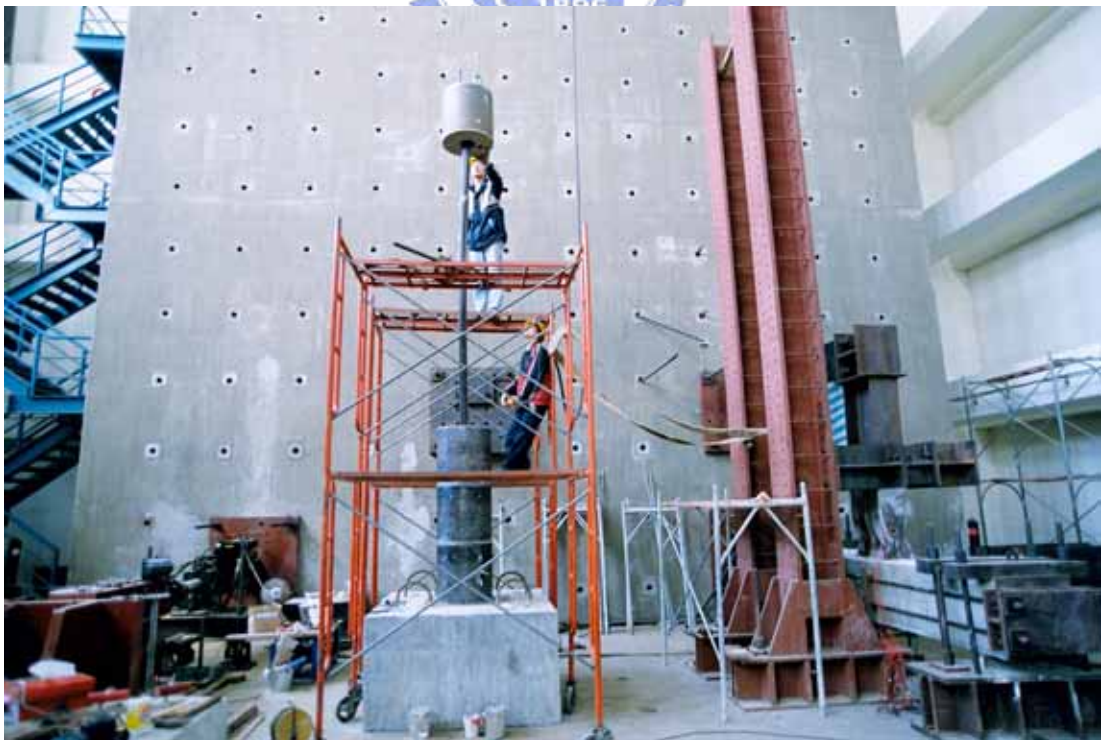
照片 3.14 第四節塊吊裝
