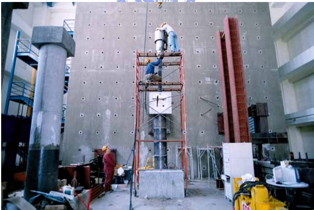
照片 3.16 吊裝施拉預力的油壓千斤頂
