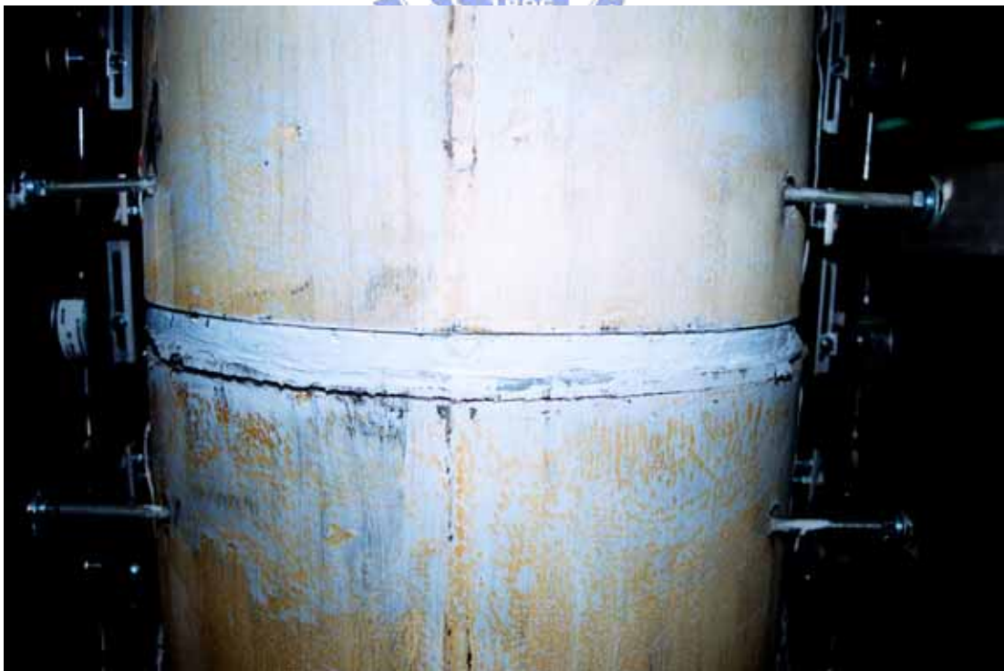
照片 3.42 試體 SP1 第一、二節塊間混凝土裂縫長度 ( \theta = +0.06 弧度)
