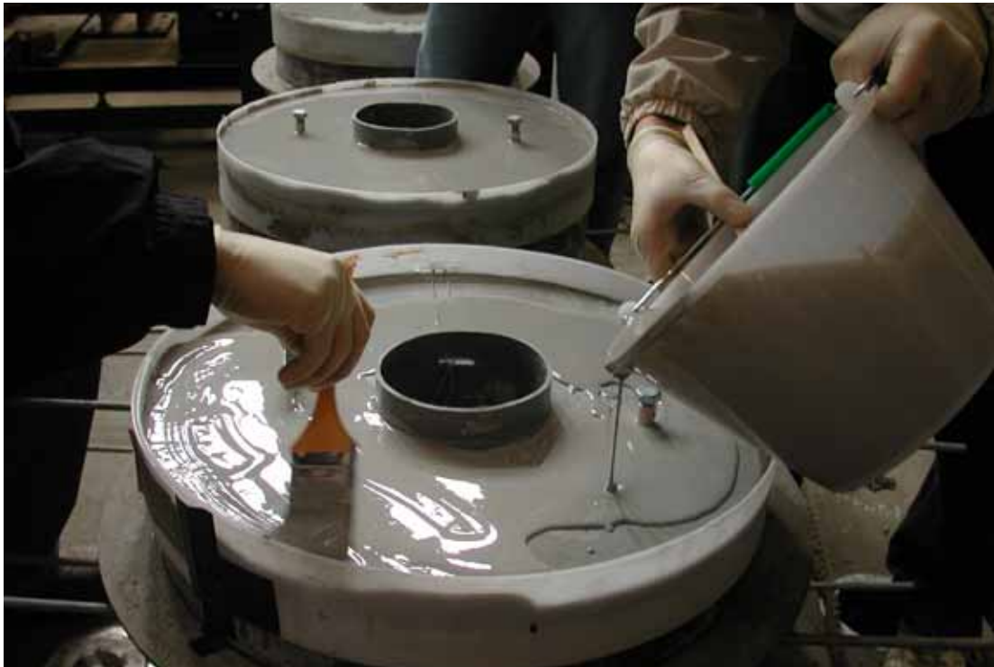
照片 3.7 流動性環氧樹脂施工情形
