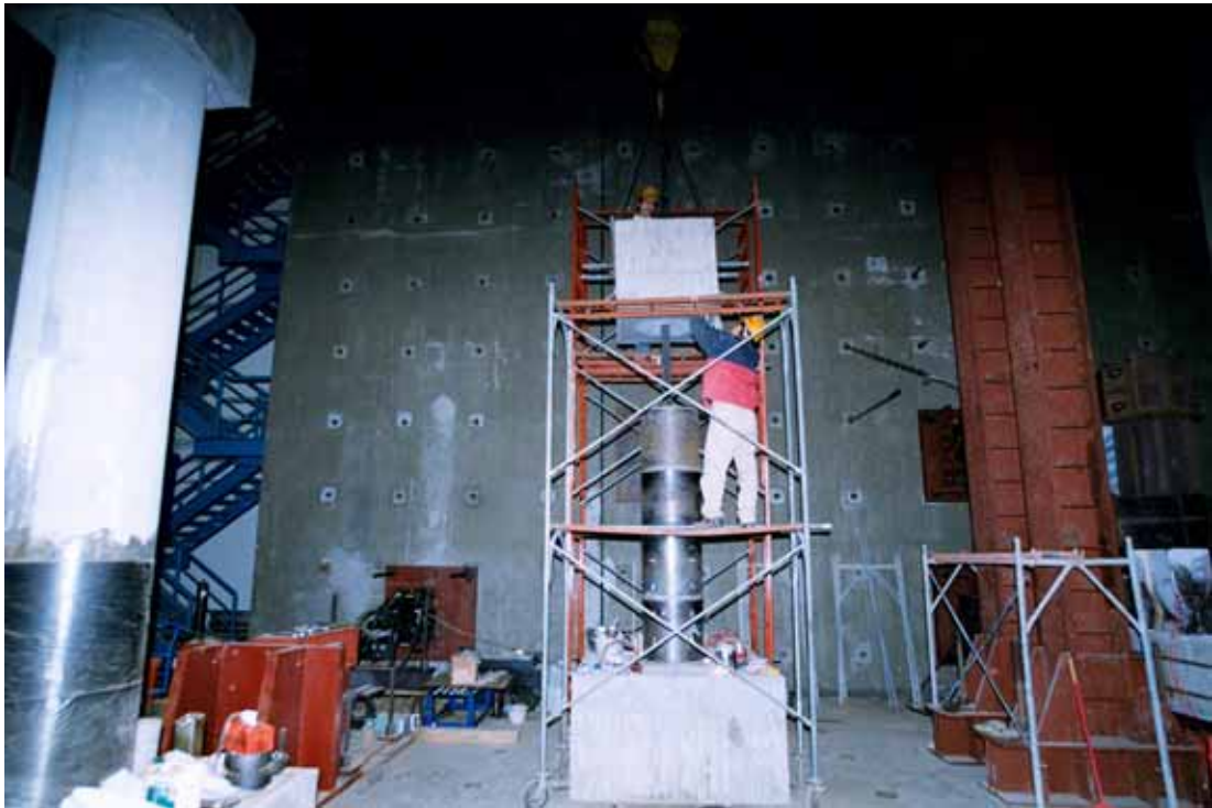
照片 3.15 柱頂錨錠節塊吊裝
