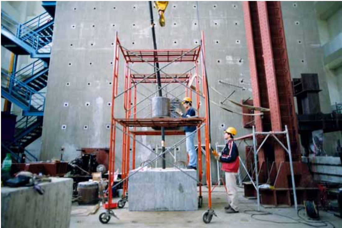
照片 3.11 第一節塊吊裝
