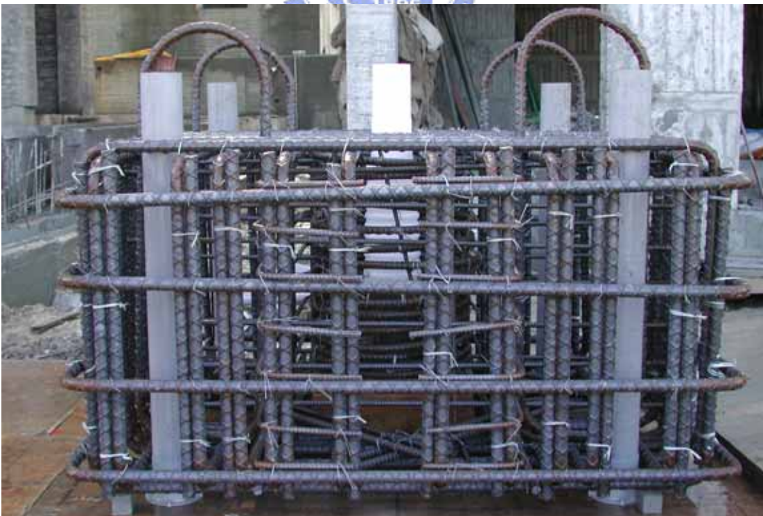
照片 3.2 基礎鋼筋籠
