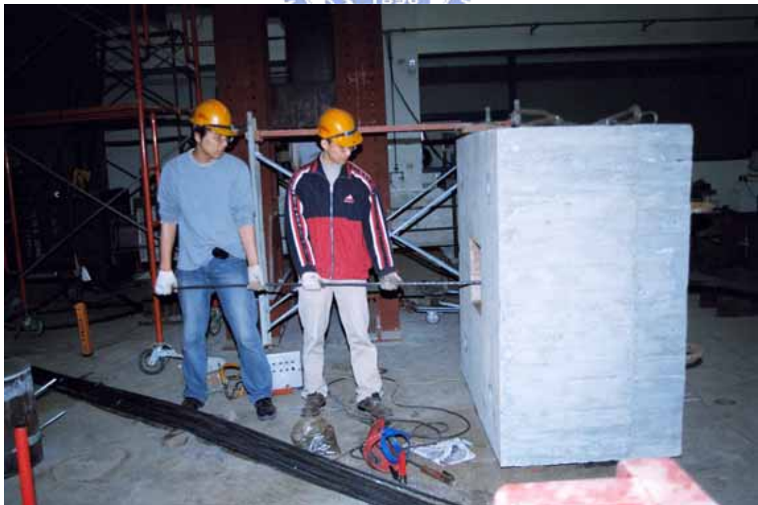
照片 3.8 基礎底部鋼鉸線定位
