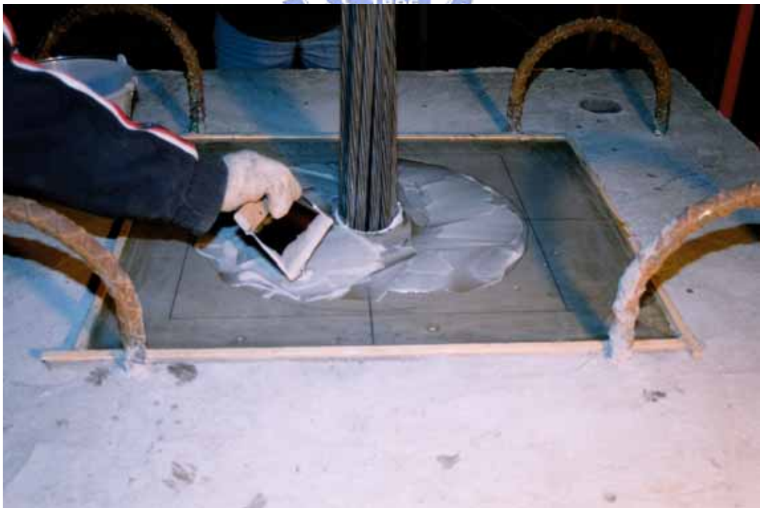
照片 3.10 基礎面上塗抹高稠度環氧樹脂
