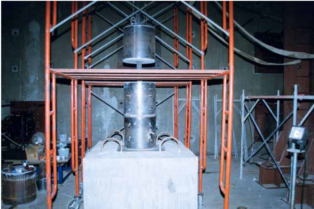
照片 3.13 第三節塊吊裝
