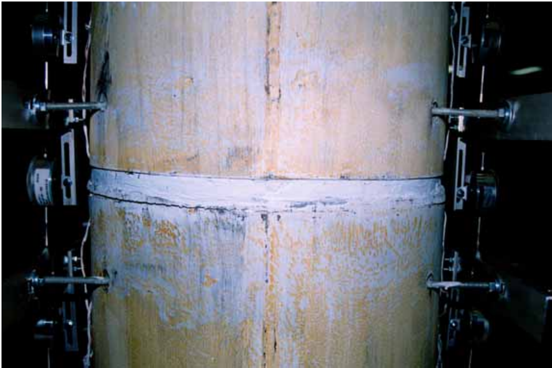
照片 3.29 試體 SP1 第一、二節塊間混凝土裂縫長度 ( \theta = +0.03 弧度)
