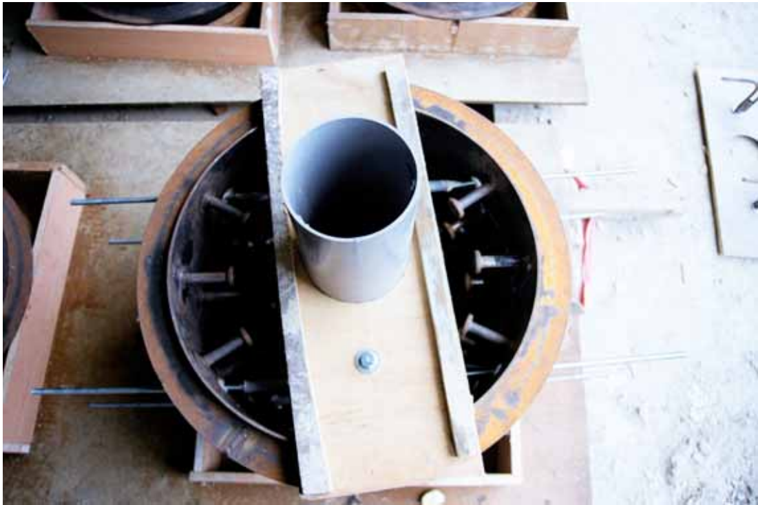
照片 3.1 鋼套管混凝土節塊 PVC 管定位
