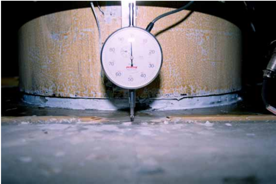
照片 3.23 試體 SP1 柱底部混凝土剝落 ( \theta = +0.02 弧度)
