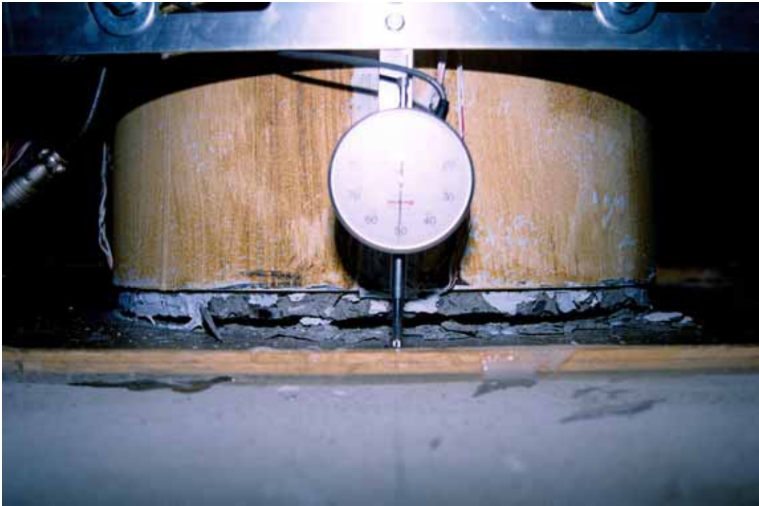
照片 3.31 試體 SP1 柱底部混凝土裂縫 ( \theta = +0.04 弧度)
