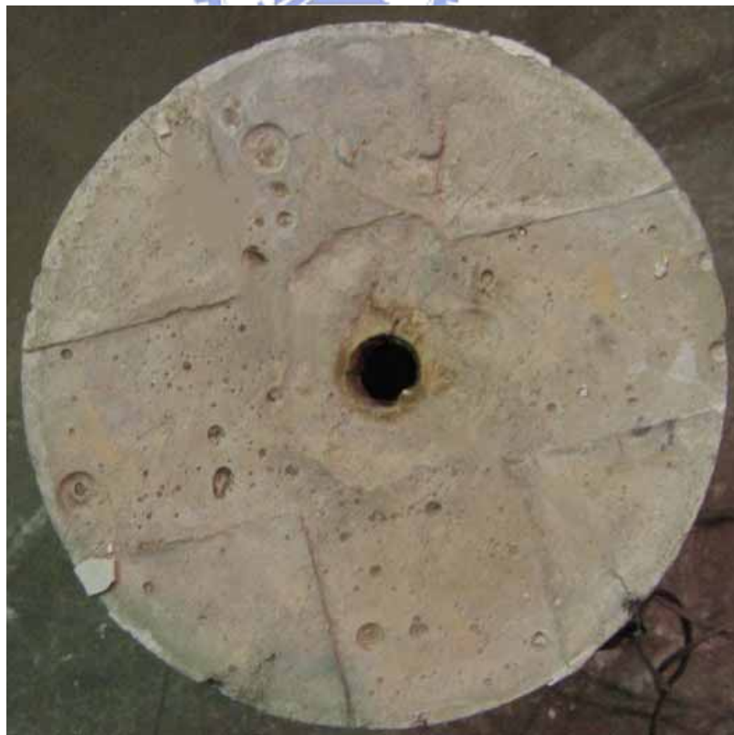
圖 4-24 300°C 下纖維棒直徑 20mm 埋置長度為 4\phi 之混凝土試體破壞模式
