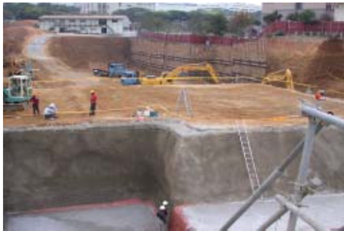
圖 4.12 基礎開挖完成之量測現況
