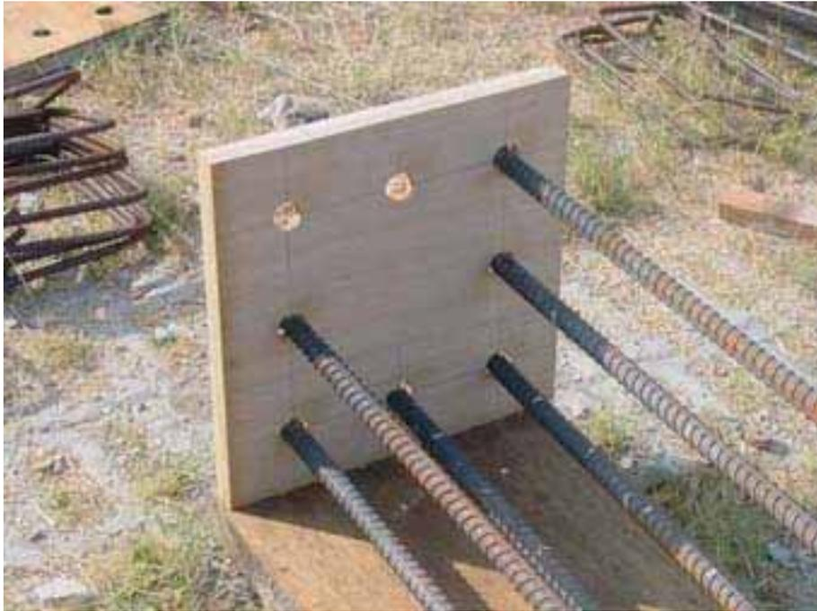
照片 三 柱主筋穿過柱端部模板
