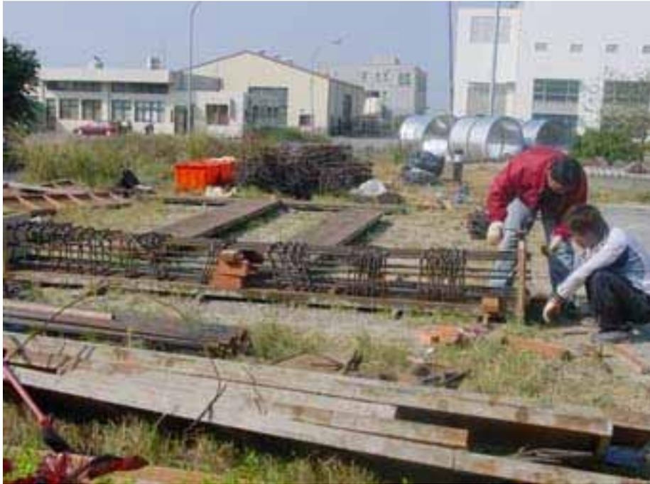
照片 五 穿入另一柱端模板
