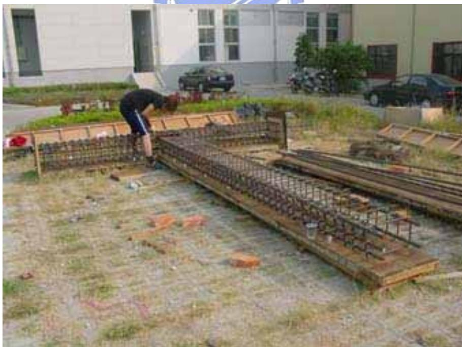
照片 八 綁紮梁箍筋
